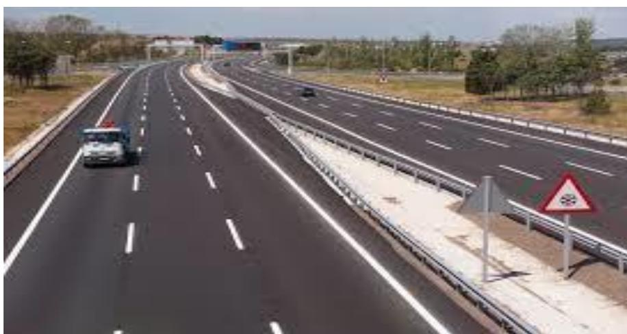
La figura No 02 muestra una autopista de segunda clase, la superficie de rodadura es de pavimento flexible, de calzadas divididas por medio de un separador central; cada calzada cuenta con tres carriles que proporcionan flujos vehiculares continuos.
