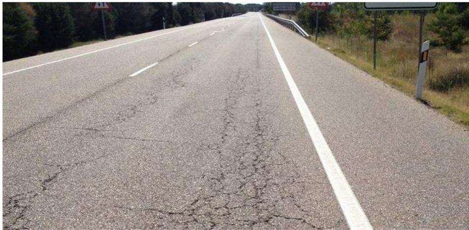
La figura No 04 muestra las fallas de la superficie de rodadura del pavimento flexible de una carretera de segunda clase, su evaluación determinará el estado en que se encuentra para su respectivo mantenimiento.
