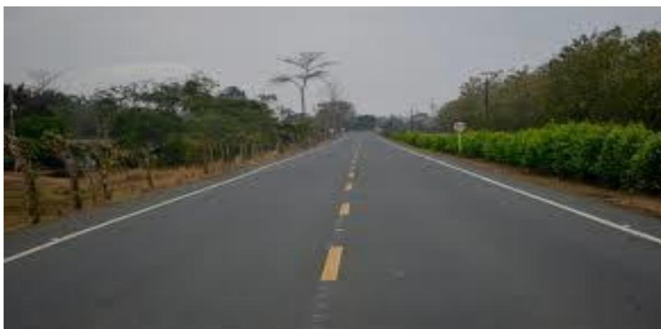
La figura No 02 muestra la construcción de una carretera de Segunda Clase, con una calzada de dos carriles de 3.30 m. de ancho como mínimo y con una superficie de rodadura de pavimento flexible
