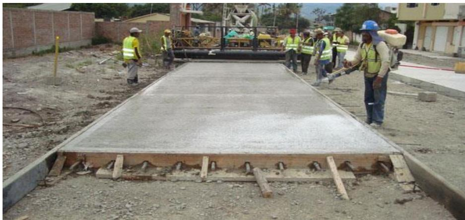
La figura No 03 muestra la construcción de una carretera de segunda clase, con una calzada de dos carriles de 3.30 m. de ancho como mínimo y con una superficie de rodadura de pavimento rígido reforzado con acero.
