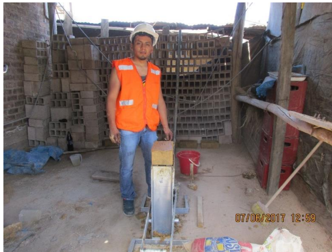
Figura 13. Elaboración de adobes con la maquina CINVA RAM.
