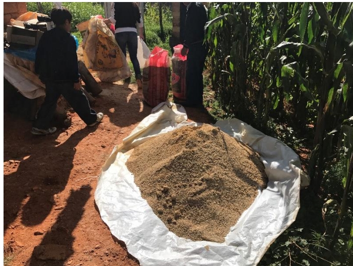
Fotografía N° 2. Recolección y tamizado del material extraído de la cantera
