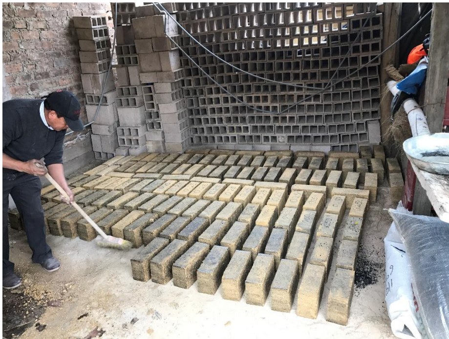
Fotografía N° 16. Secado de adobes compactados con los distintos porcentajes de caucho triturado de neumático.
