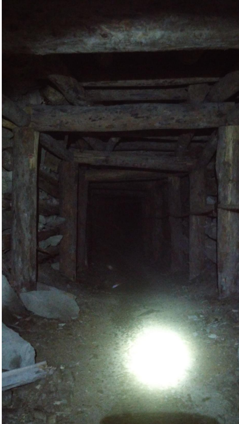
Fotografía 1. Acceso a las labores
