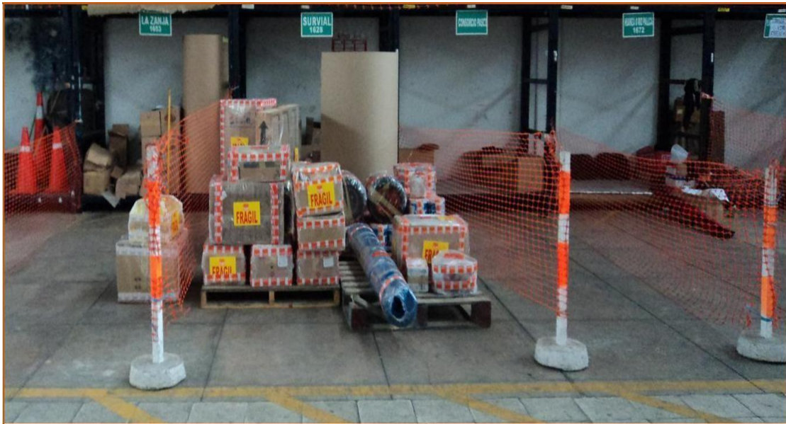
Figura n.º 7 Zona de almacén
