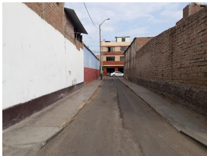
Figura 78: Inspección visual de Pasaje S/N.
