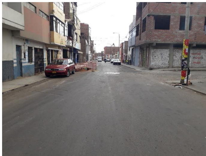
Figura 74: Inspección visual de calle Puno.
