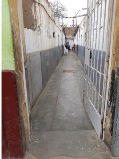
Figura 85: Inspección de pasajes típicos de viviendas en Aranjuez.
