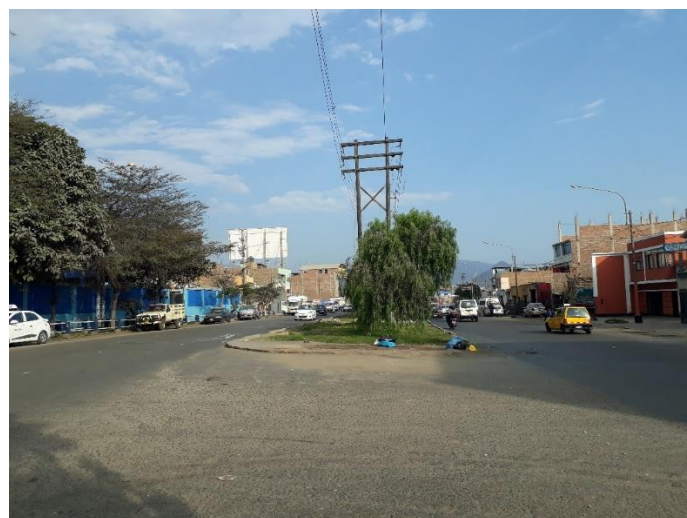
Figura 75: Inspección visual de Avenida América.
