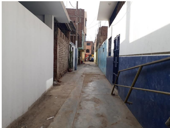
Figura 76: Inspección visual de Pasaje Majes.
