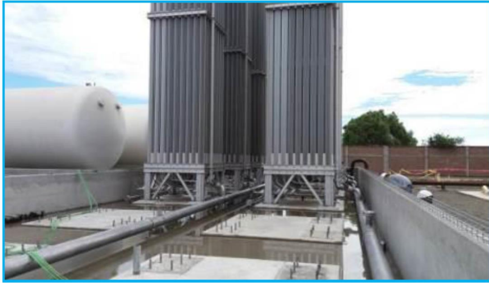
Figura 8: Vista de la Estación de Distrito Trujillo, Zona de Regasificadores (Gases del Pacífico S.A.C., 2013)
