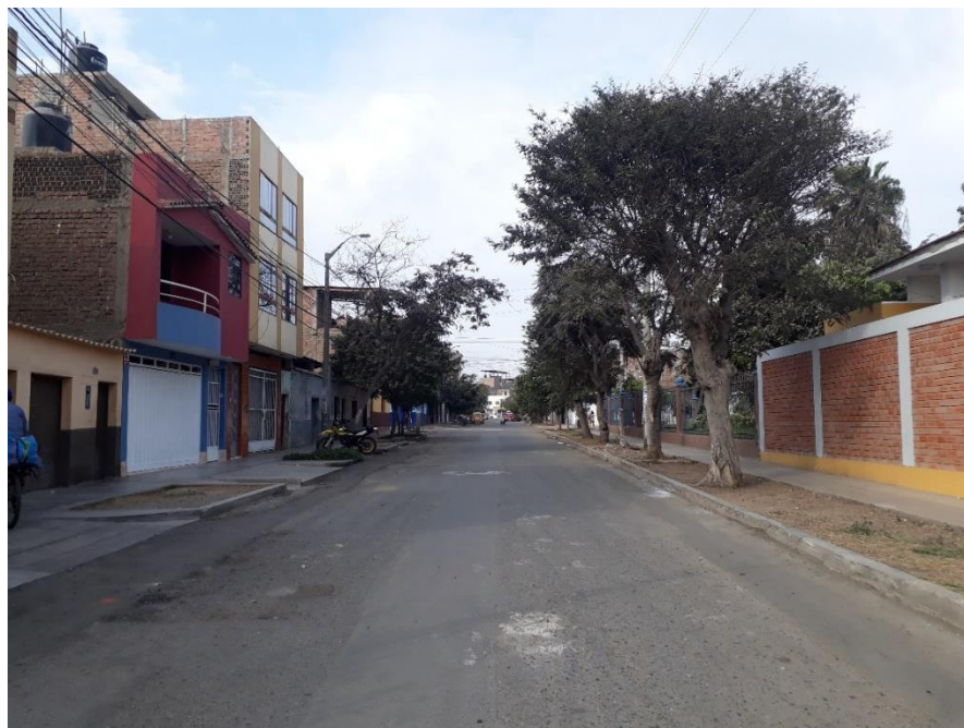
Figura 81: Inspección visual de Calle Chiclayo.
