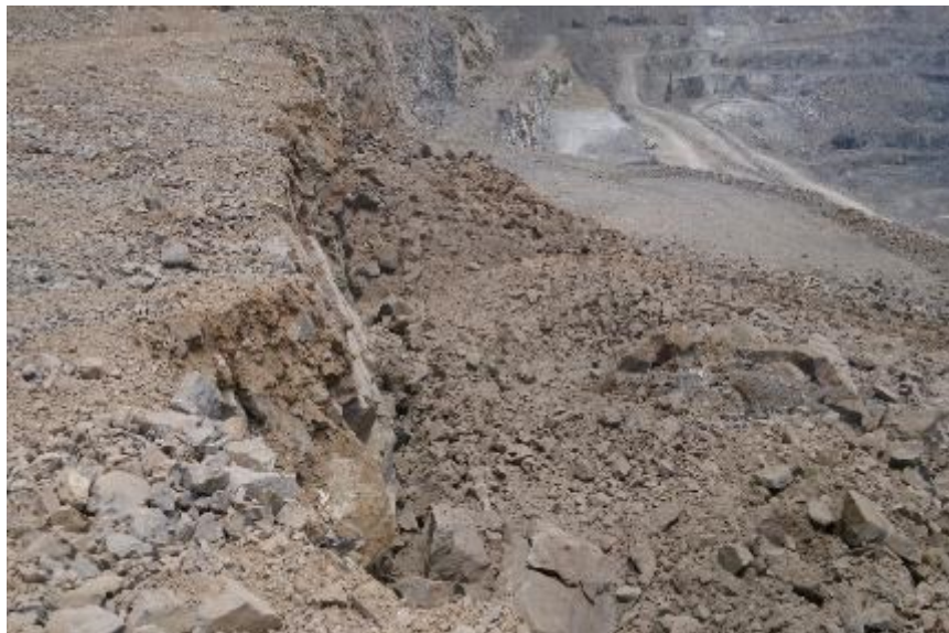
Foto 6 área frente volado con sobre rotura.
