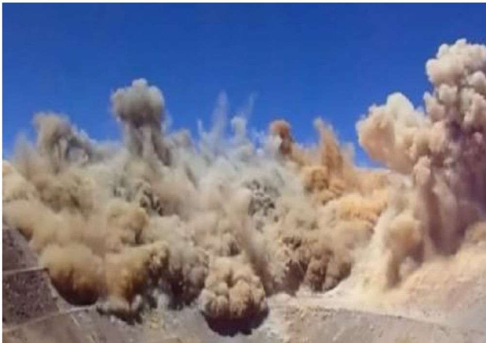
Figura 10 Disparo Proyecto 4208-29 (Sin humos naranjas) Fuente: Elaboración propia.
