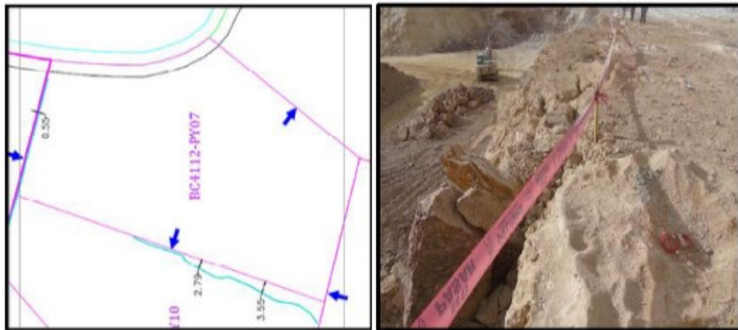
Figura 15 Sobrerotura del macizo rocoso del proyecto 4112-07 disparado con HA.
