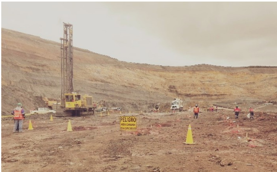
Foto 8 Plataforma lista para el inicio de la voladura.
