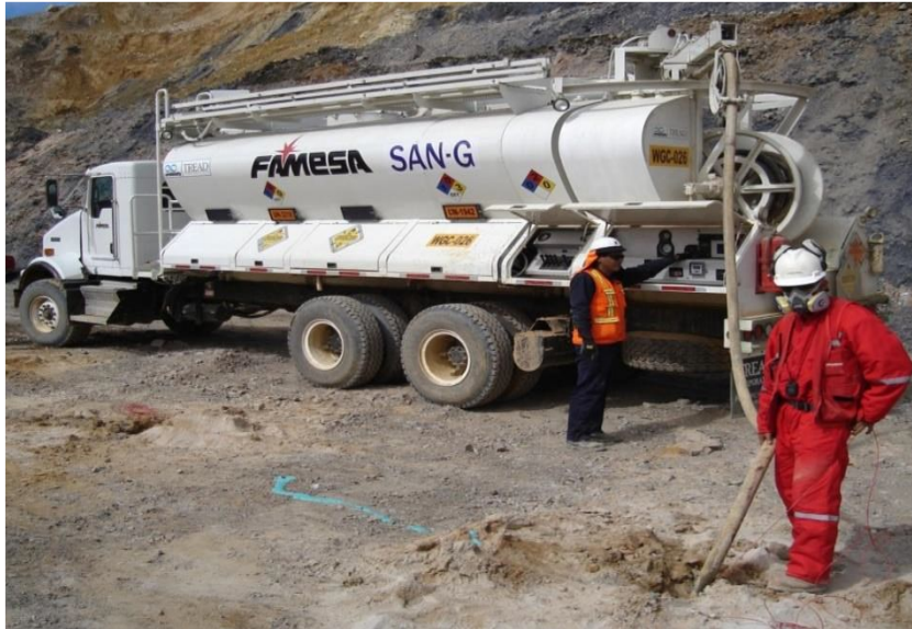
Foto 5 Camión fábrica de FAMESA cargando SAN-G al taladro.
