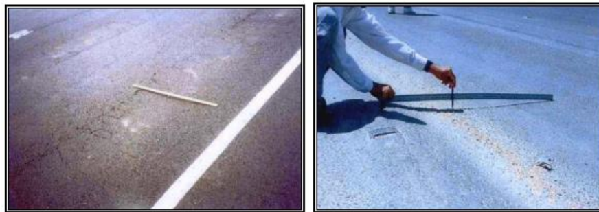
Figura 12: Deformaciones plásticas en los pavimentos asfálticos.
