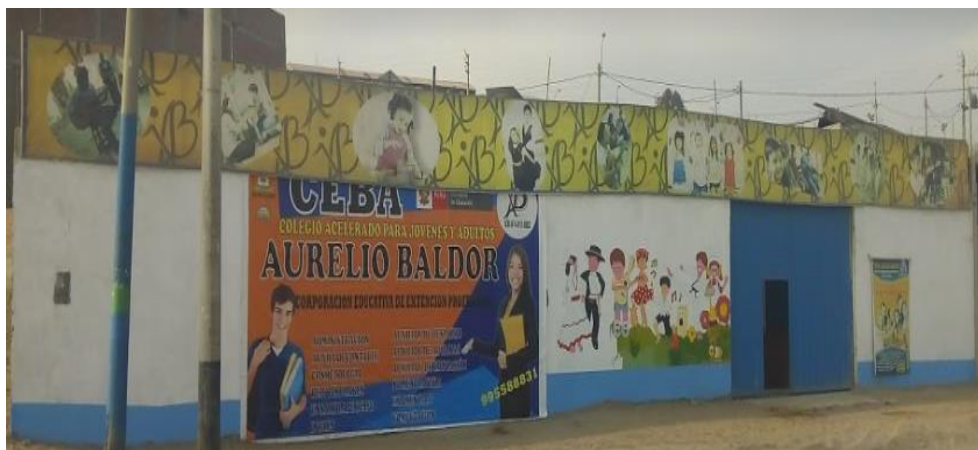
Figura n.º 19. Fachada del CEBA Aurelio Baldor
