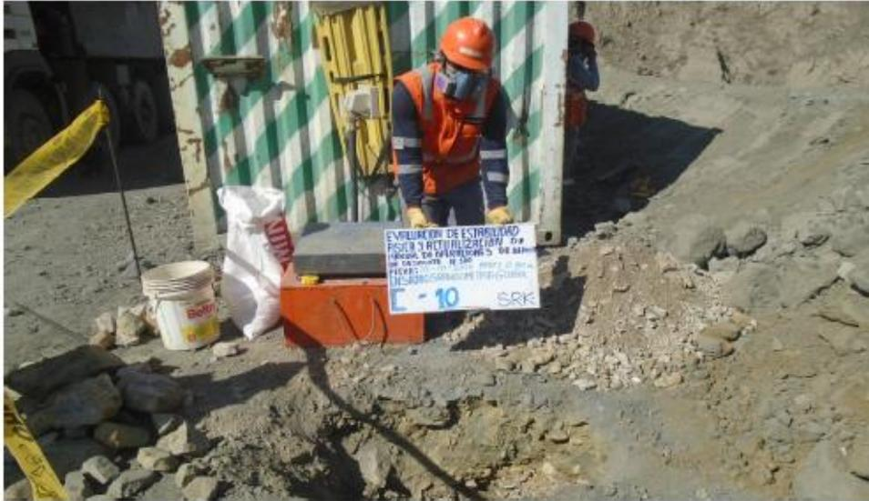
Foto N°19: Calicata C-10 (prof. 0.80 m), realizado en la corona del depósito de desmonte.
