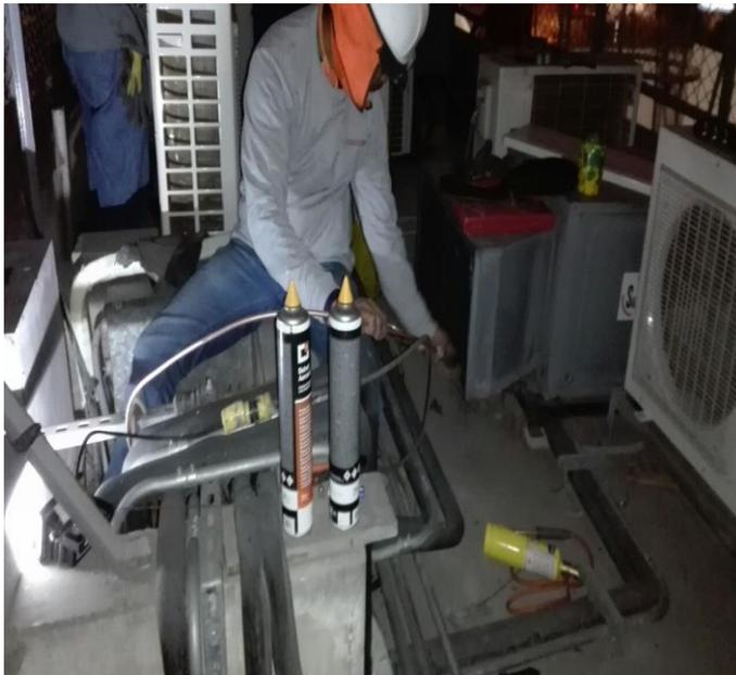
*Figura 0.2 Soldadura de tubería de cobre en reparación de aire acondicionado.*
