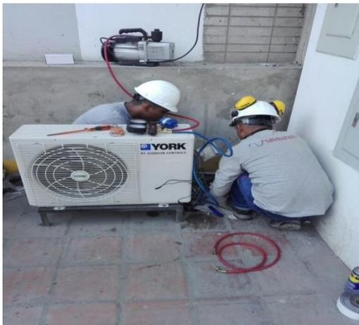
*Figura 0.4* Vaciado de sistema en reparación de aire acondicionado.
