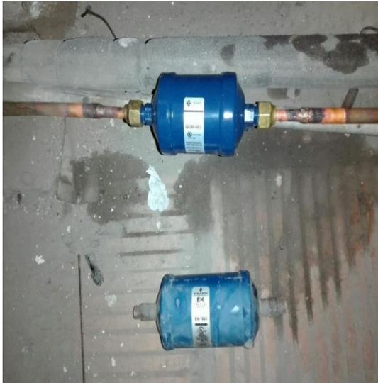
*Figura 0.3* Cambio de filtro secante de aire acondicionado.
