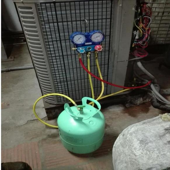
*Figura 0.5* Recarga de gas refrigerante a equipo de aire acondicionado.
