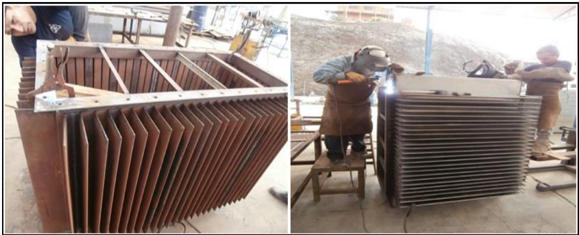
Figura n.º 3.1.1.13 Fabricación de tanque
