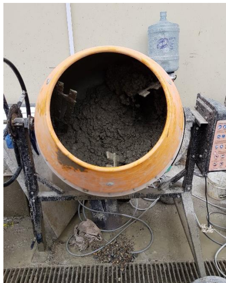
Figura 37: Elaboración de la mezcla de concreto.
