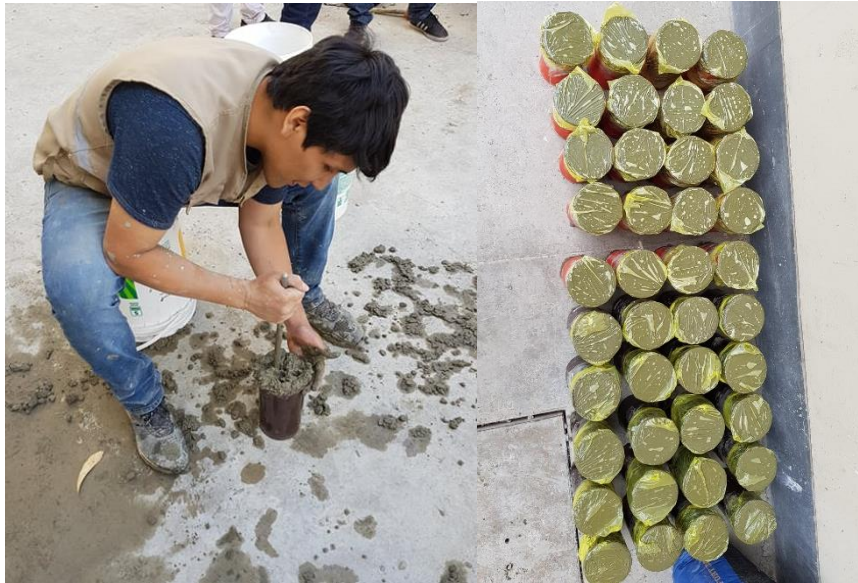
Figura 38: Elaboración de probetas de concreto 4'' x 6''.
