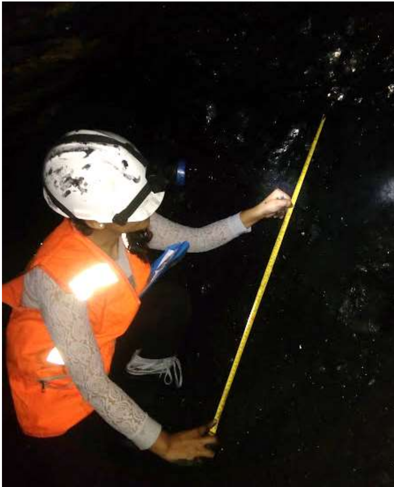
Figura 4. Persistencia de las discontinuidades
