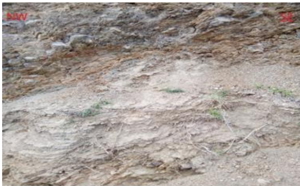
Figura 09. Frente de suelo parte basal del talud a estudiar.
