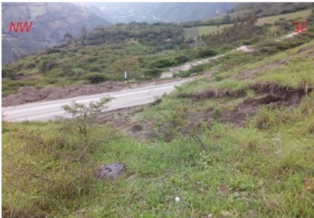
Figura 29. Evidencia de deslizamiento de suelo al costado del talud 139 (450 al 500).
