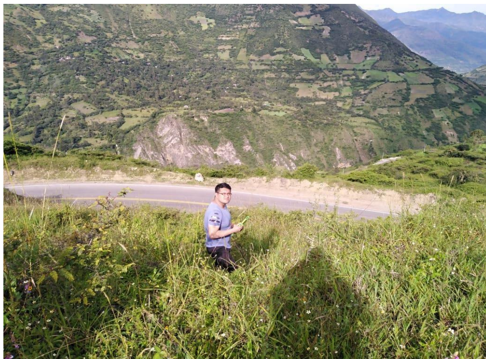
Figura 36. Toma de medida de la dimensión del Talud Parte 04
