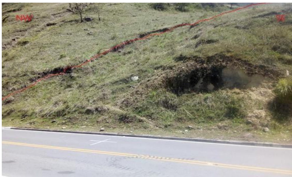
Figura 05. Talud margen izquierdo ubicado a 139 (500 al 450).
