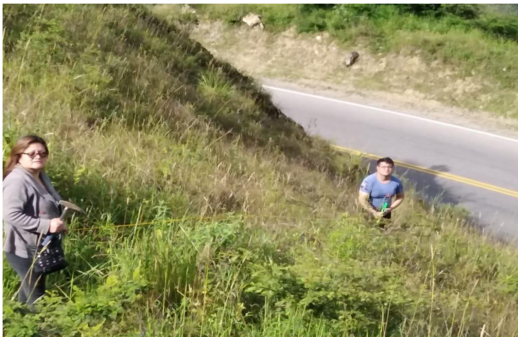
Figura 34. Toma de medida de la dimensión del Talud Parte 02
