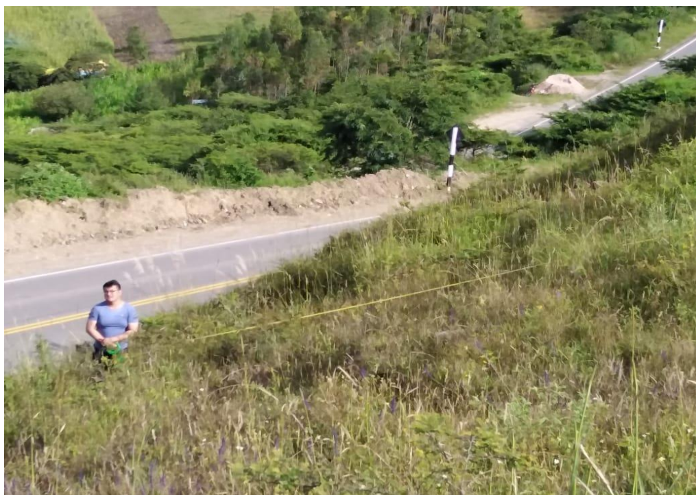
Figura 38. Toma de medida de la dimensión del Talud Parte 06
