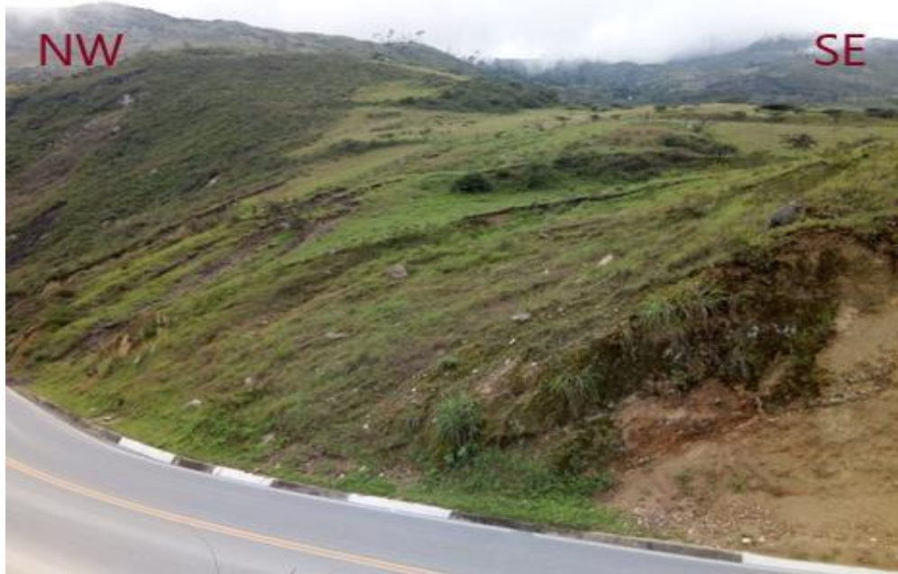
Figura 04. Talud de la carrera San Juan.
