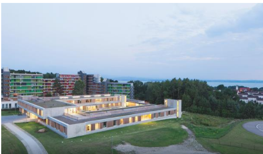
FIGURA 18: VISTA PAN. – C. PSIQ. FRIEDRICHSAFEN FUENTE: ARCHDAILY
