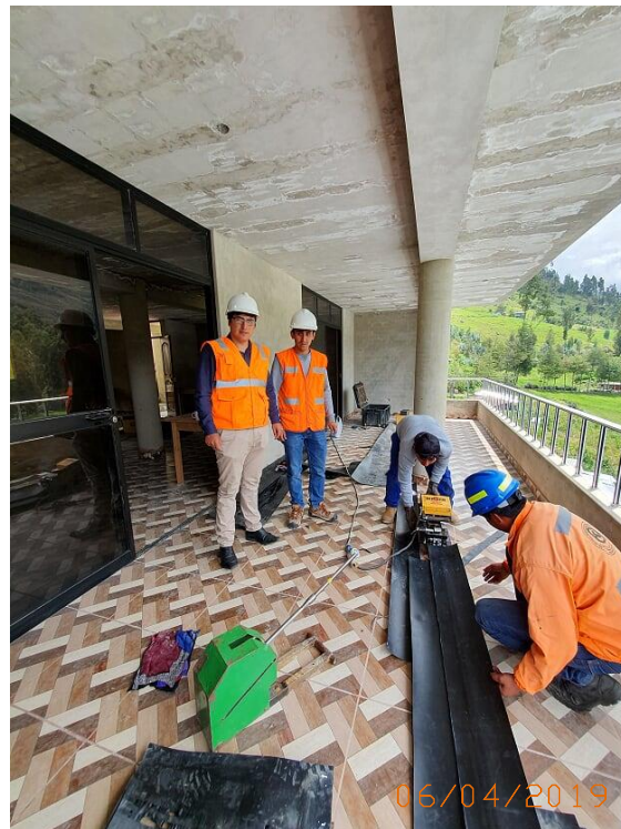
Fotografía 21 Soldadura por fusión
