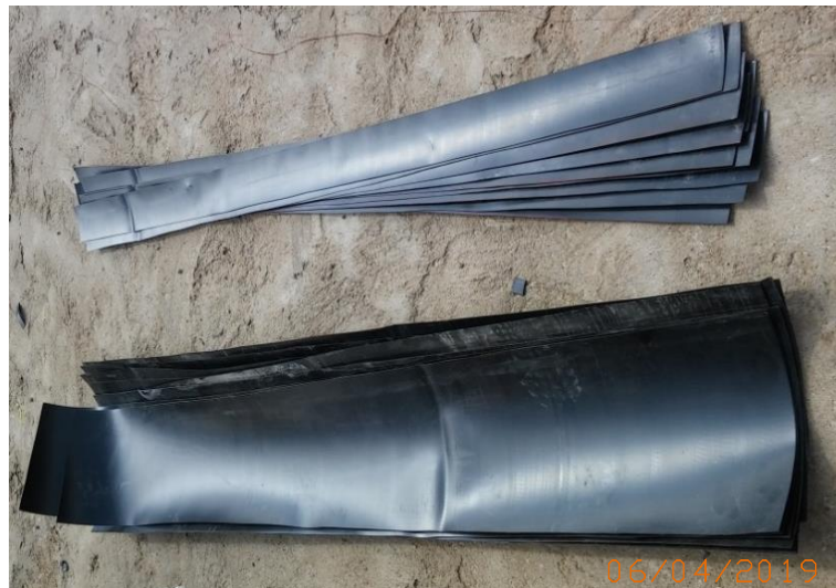
Fotografía 1 Habilitación de geomembrana.
