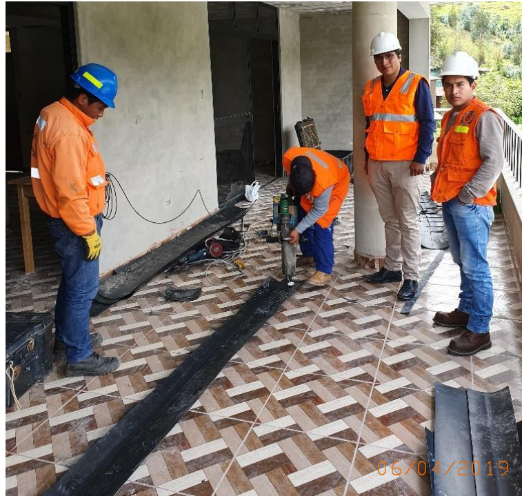
Fotografía 5 Soldadura por extrusión.
