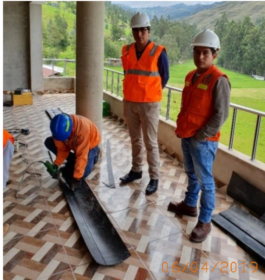
Fotografía 3 Unión de las geomembranas.
