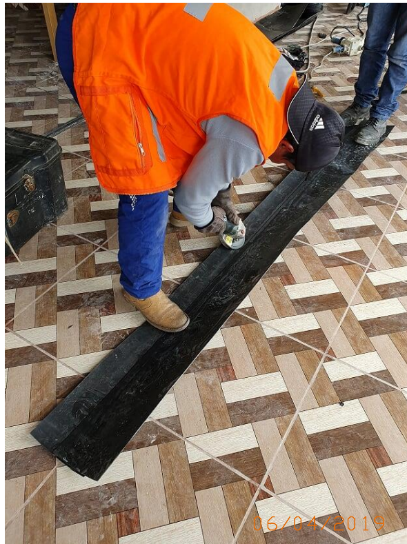
Fotografía 19 Amolado en la unión de los paneles.
