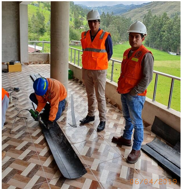
Fotografía 18 Unión de paneles con aire forzado caliente.
