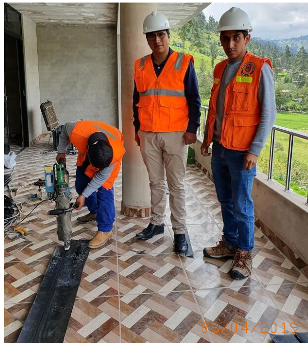
Fotografía 20 Soldadura por extrusión
