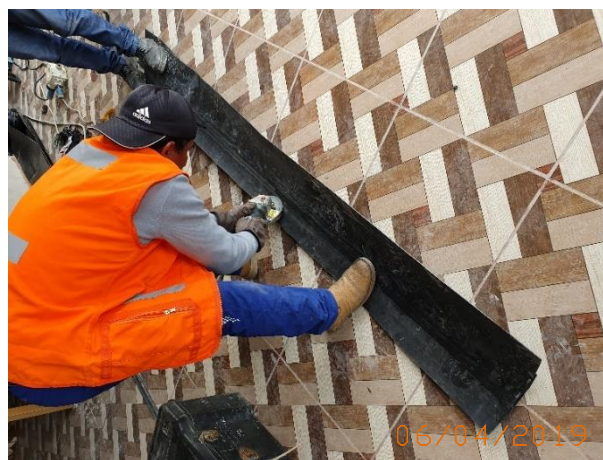
Fotografía 4 Amolado de la geomembrana
