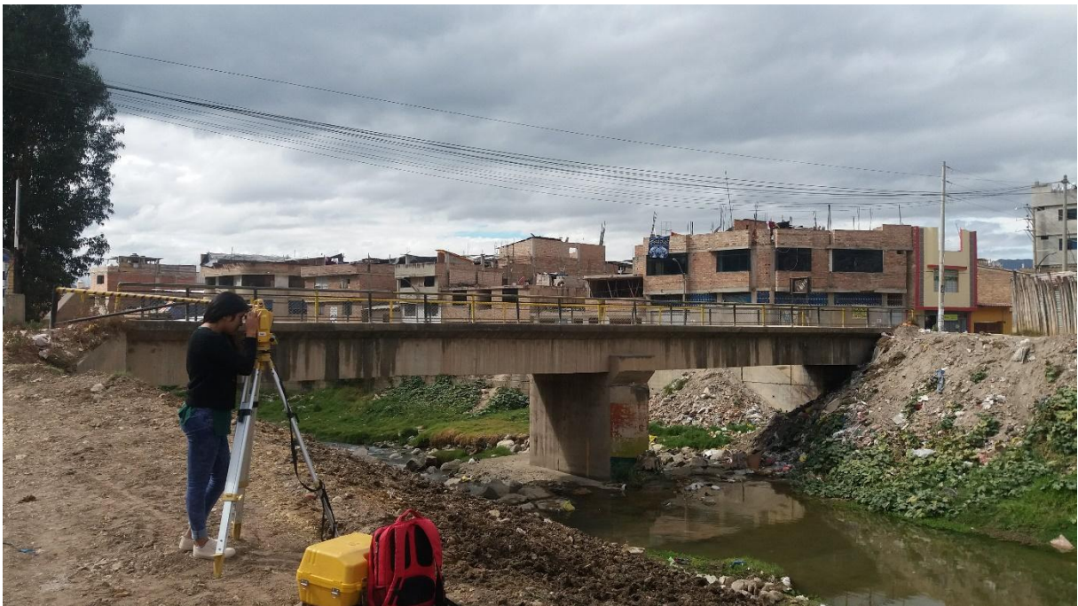
Ilustración 4: Radiando puntos en la ladera del río Mashcón
