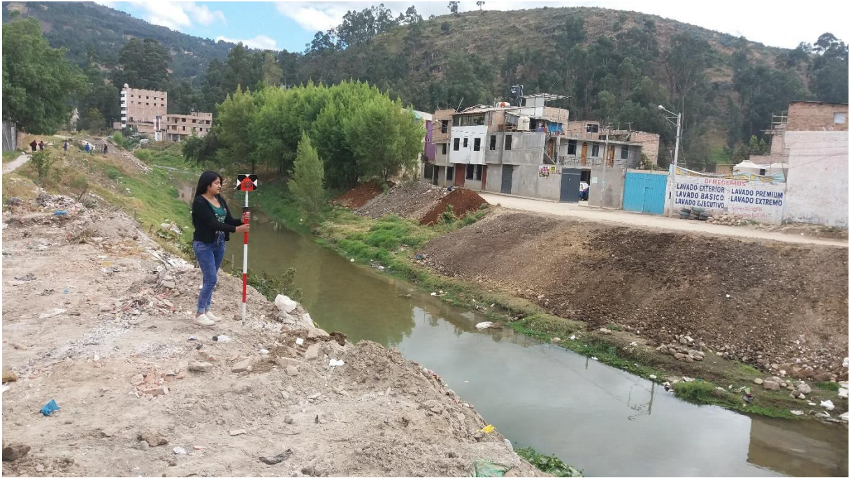
Ilustración 7. Levantamiento topográfico fuera del río
