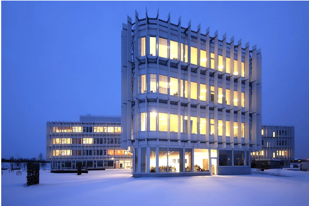
Figura 06: Vista de la Fachada
