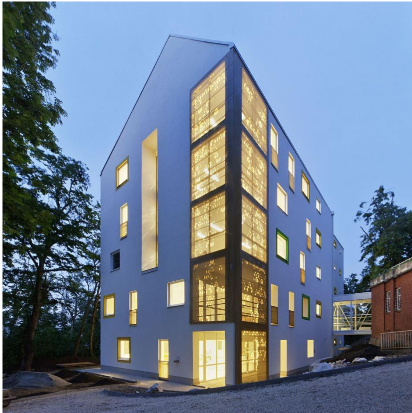
Figura 05: Vista de la Fachada
