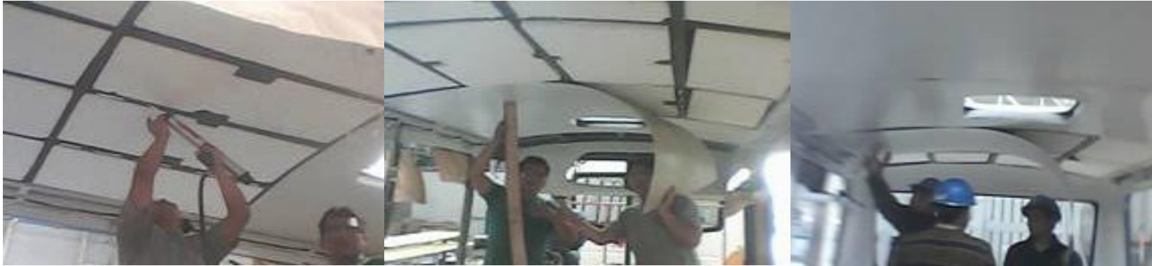
Figura 19: Toma de imágenes de habilitado de techo
