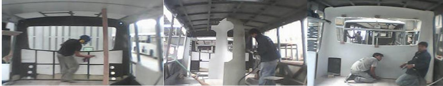
Figura 15: Imágenes tomadas del forrado interior posterior
