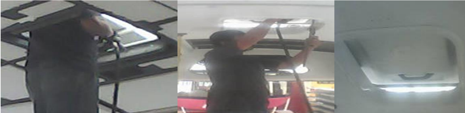
Figura 23: Imágenes tomadas del montaje de la tapa de claraboya.
