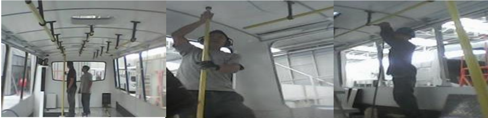
Figura 25: Imágenes tomadas del montaje del pasamanos del salón.
