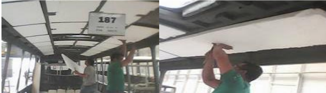
Figura 17: Imágenes tomadas del habilitado de techo
