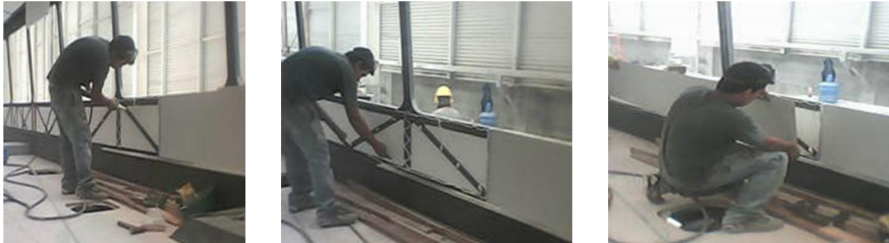
Figura 13: Imágenes de forro interior Lateral
