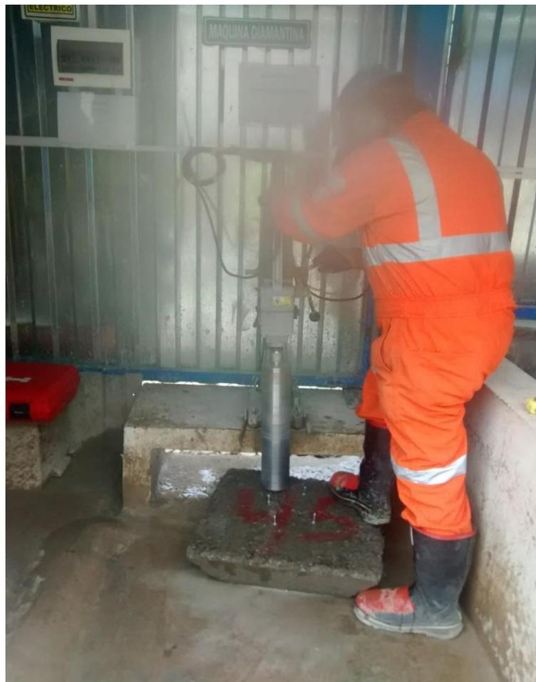
*Figura 17.* Extracción de testigos con máquina diamantina.
