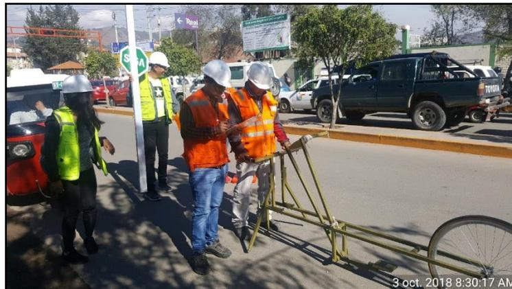
*FOTOGRAFÍA N° 20:* Lectura de la irregularidad del pavimento para el kilómetro km 00+ 070m
