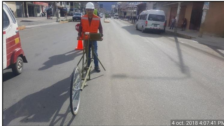
*FOTOGRAFÍA N° 40:* Irregularidades del pavimento carril W(oeste) - E(este) interno.
