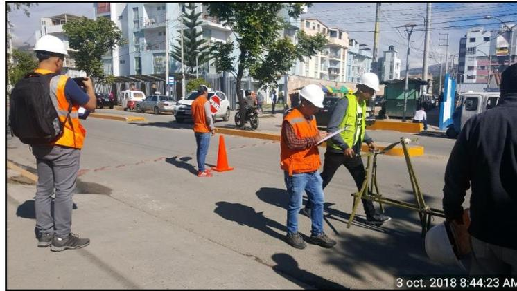
*FOTOGRAFÍA N° 22:* Lectura de la irregularidad del pavimento para el kilómetro km 00+130m.
