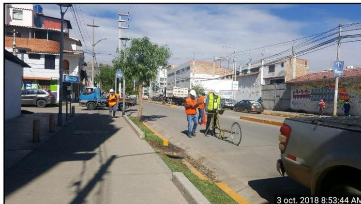
*FOTOGRAFÍA N° 24:* Lectura de la irregularidad del pavimento para el kilómetro 0km+ 270m.
