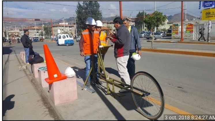
*FOTOGRAFÍA N° 16:* Guía del Ing. Jhan Torres para la toma de irregularidades del pavimento. En la Av. Hoyos Rubio adecuadas con el equipo de Merlin.
