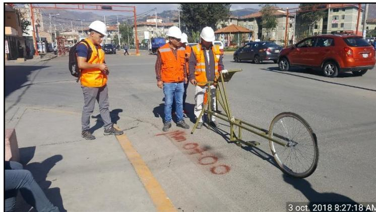
*FOTOGRAFÍA N° 17:* Primera lectura de irregularidad del pavimento. en el kilómetro 0km +000m del carril W(Oeste)- E(este) Externo.
