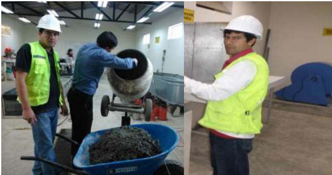
Fotografía N° 28: Realización de la mezcla de concreto
