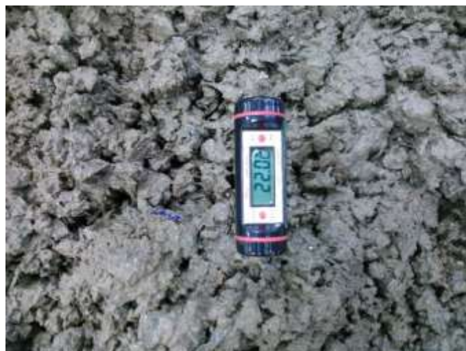
Fotografía N° 9: Midiendo la temperatura del concreto
