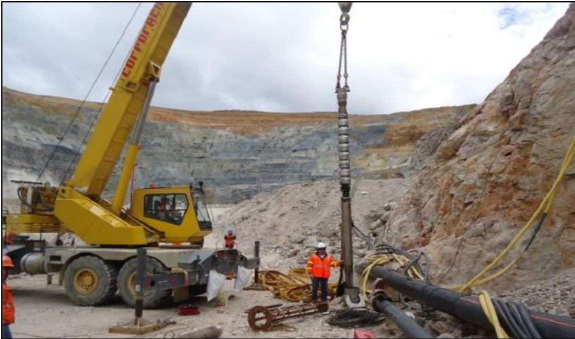
Figura 6. Instalación De Bomba Y Motor Sumergible Con Grúa De 40 Ton
