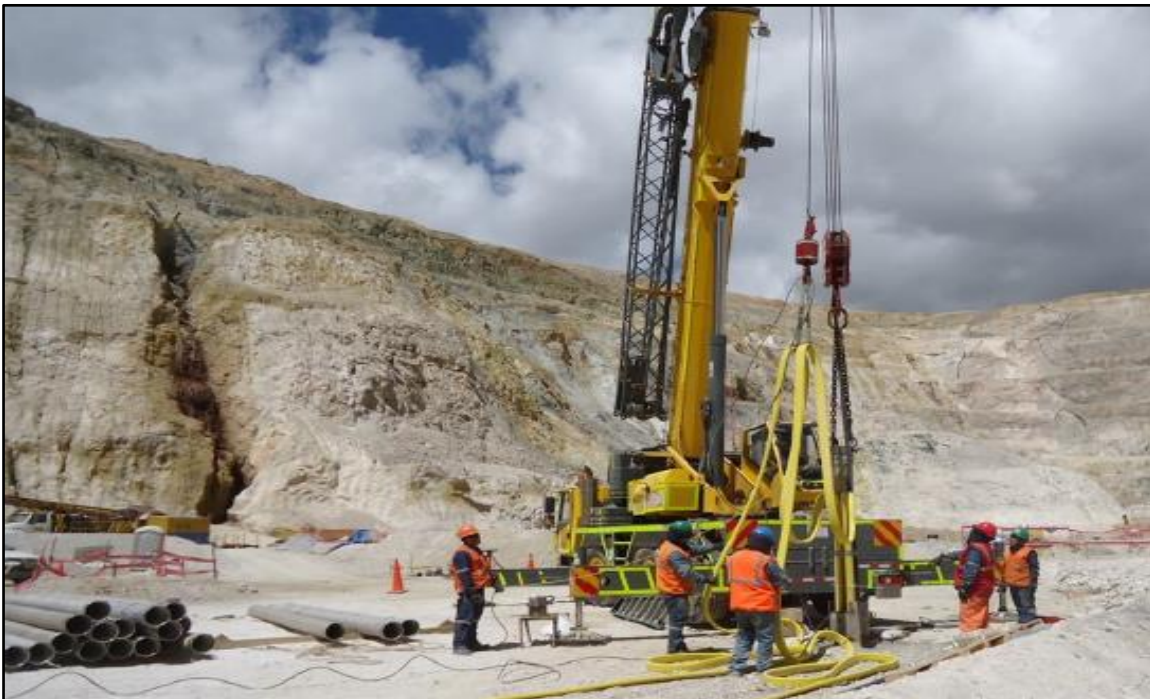
Figura 7. Instalación De Sistema De Bombeo Con Grúa De 40 Ton Doble Gancho
