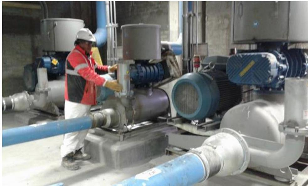
Foto 11: Sopladores volumétricos para aire de combustión horno 02
