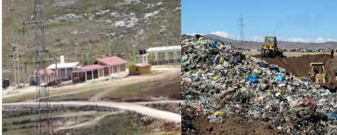
Figura N° 1.4 Planta de Tratamiento de Residuos Sólidos – Cajamarca.
