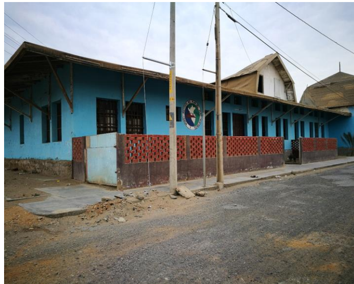
FIGURA N° 40: Vista del Inmueble de Valor Monumental ubicado en la Mz. 110 lote 2
