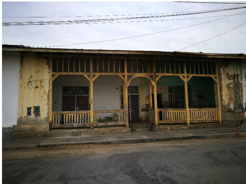
FIGURA N° 42: Vista del Inmueble de Valor Monumental ubicado en la Mz. 115 lote 11
