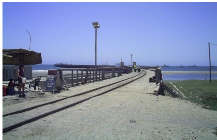
FIGURA N° 23: Vista del muelle artesanal
