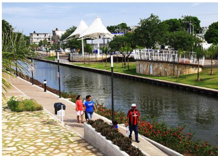
FIGURA N° 04: Canal de la Cortadura
