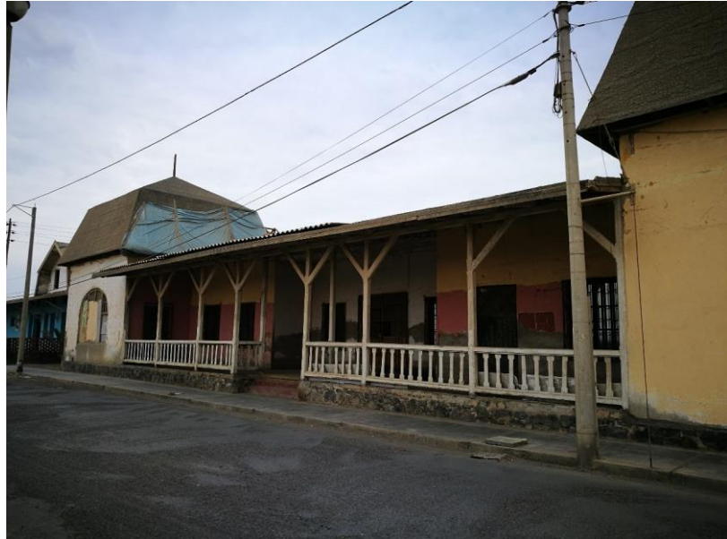
FIGURA N° 41: Vista del Inmueble de Valor Monumental ubicado en la Mz. 110 lote 1
