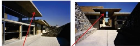
uso de cubierta con aleros
