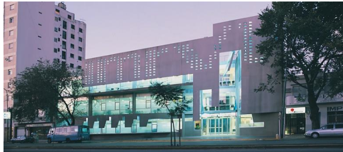
Figura N° 4: Instituto Municipal de Rehabilitación de Vicente López
