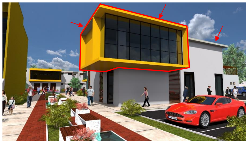
Figura n° 39: Aleros y volados en el proyecto.
