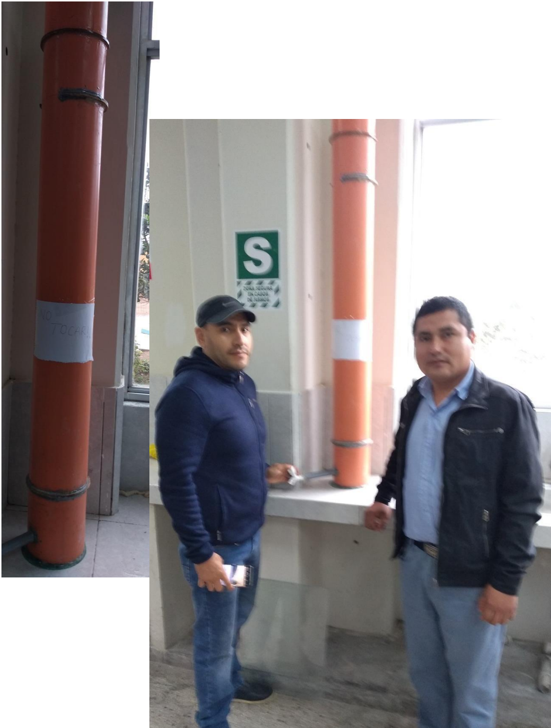
Figura A.4. Reactor de alcalinización terminado.
