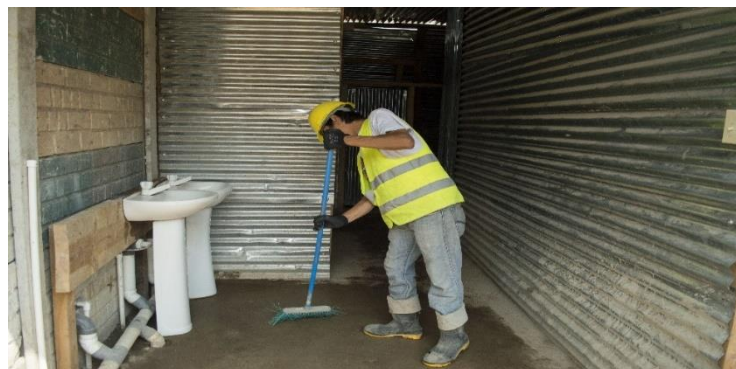
Figura 3: Orden y limpieza
