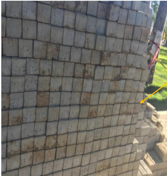
Figura 34: Área no señalizada
