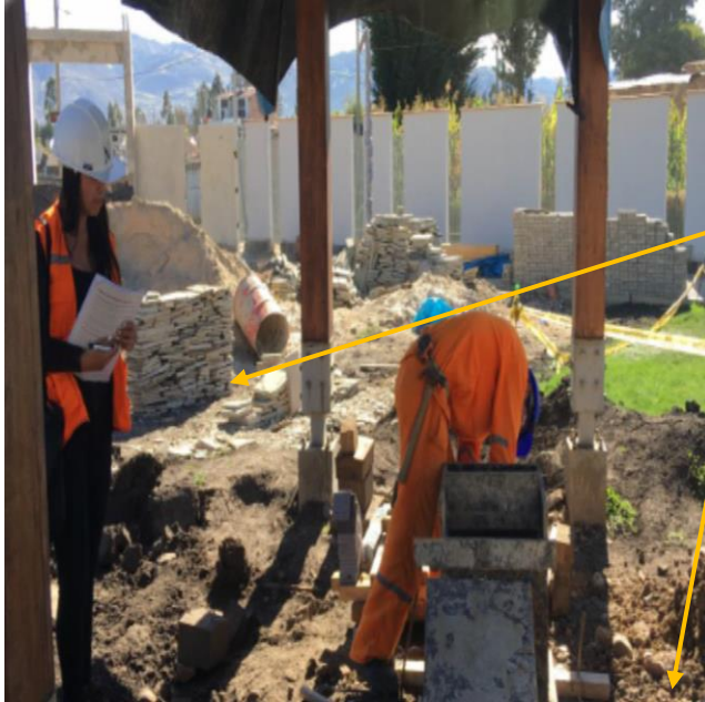
Figura 40: Evaluando en la actividad de encofrado
