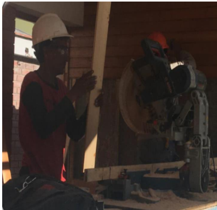
Figura 41: Colocación de madera
