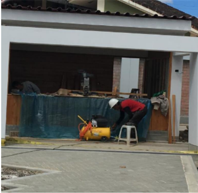
Figura 30: Actividad de colocación de madera
