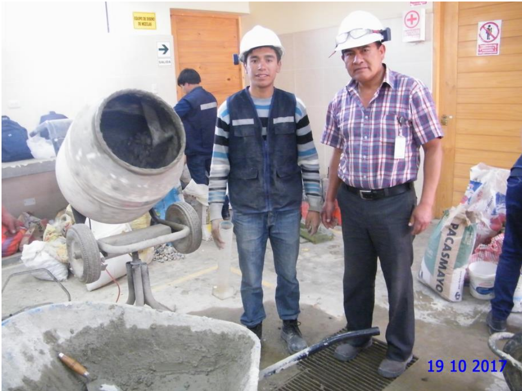
FOTO n.º 17. Elaboración del concreto.
