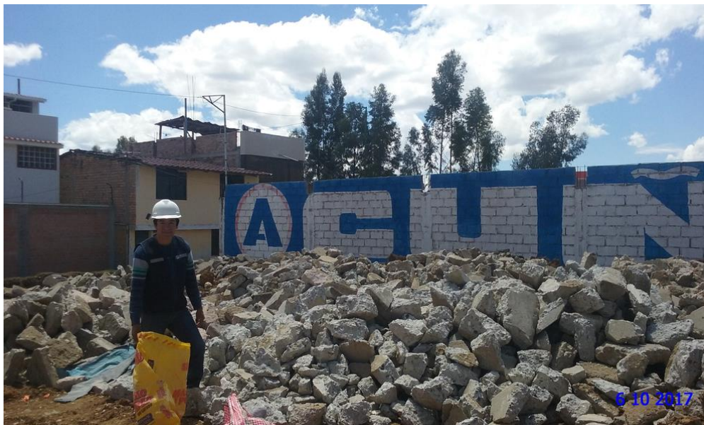
FOTO n.º 12. Extracción del concreto reciclado.
