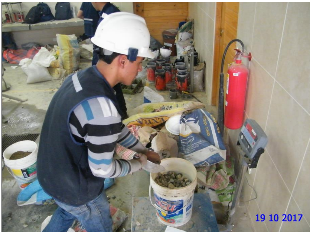
FOTO n.º 14. Peso de las cantidades de materiales para realizar la mezcla de concreto
