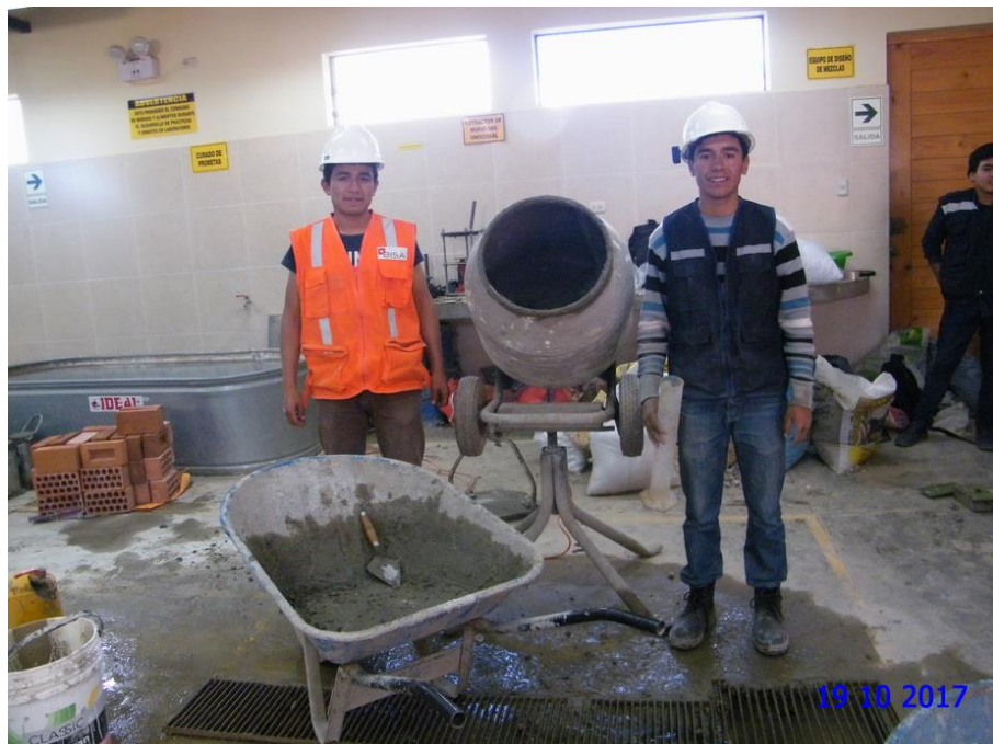
FOTO n.º 16. Elaboración del concreto.
