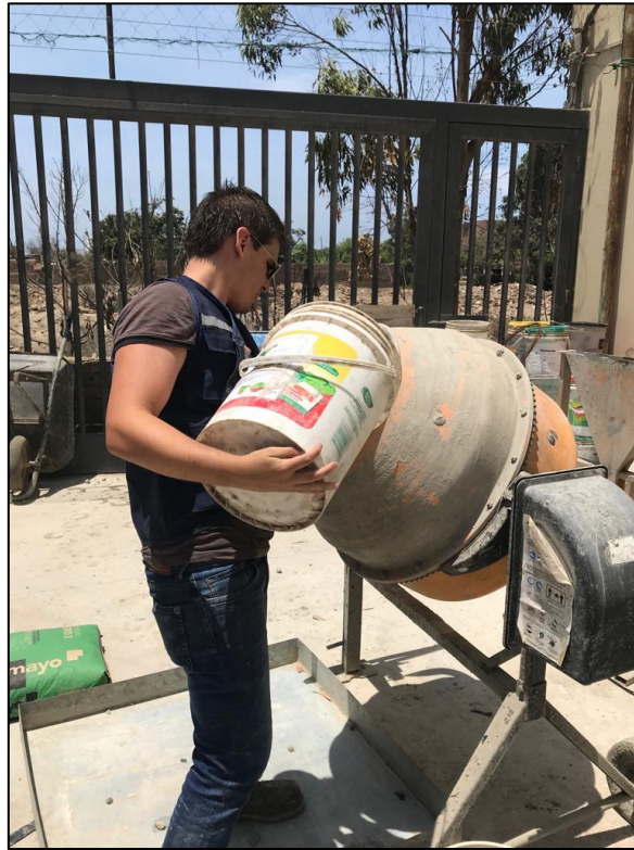
Figura N°20 Vertiendo el agregado al trompo mezclador.
