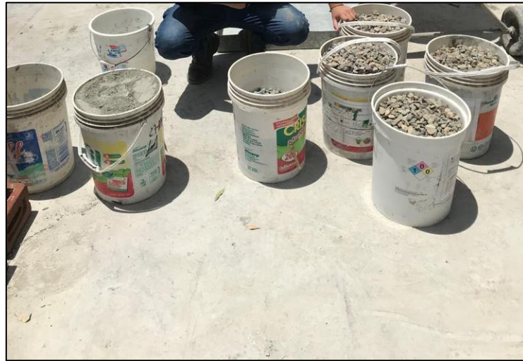
Figura N°19 Distribución de los materiales a utilizar para elaborar el concreto.
