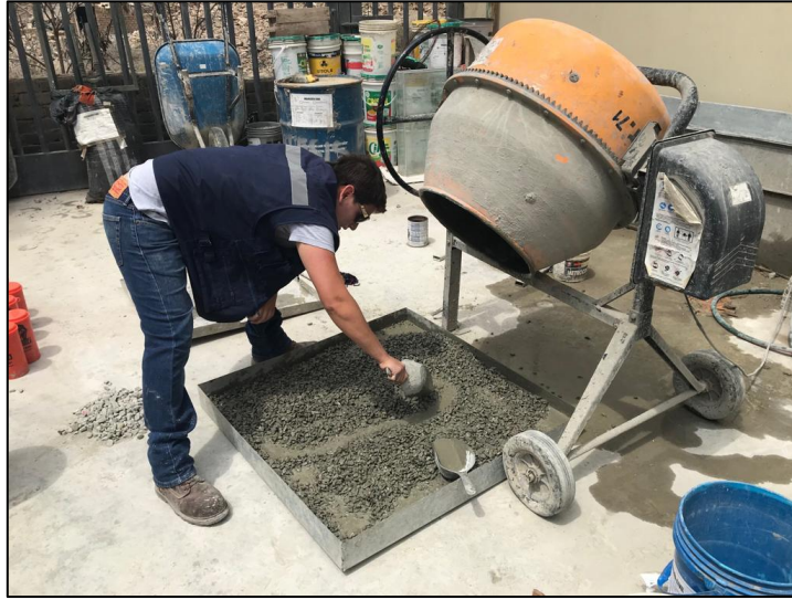
Figura N°25 Realizando la homogenización del concreto de 3/8".
