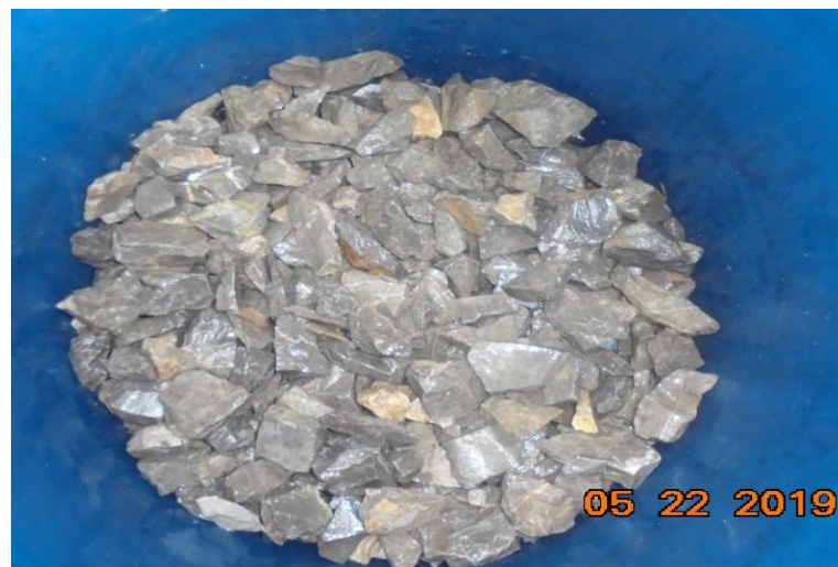
Figura 7. Colocación de la caliza triturada \Phi 1/2" (h=0.07m).
