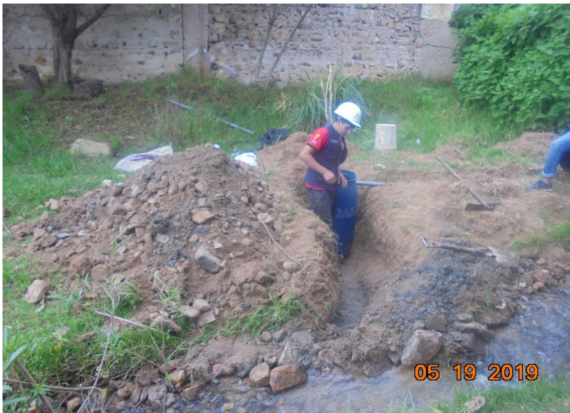
Figura 16. Instalación del filtro en la quebrada El Tambo – Llacanora.
