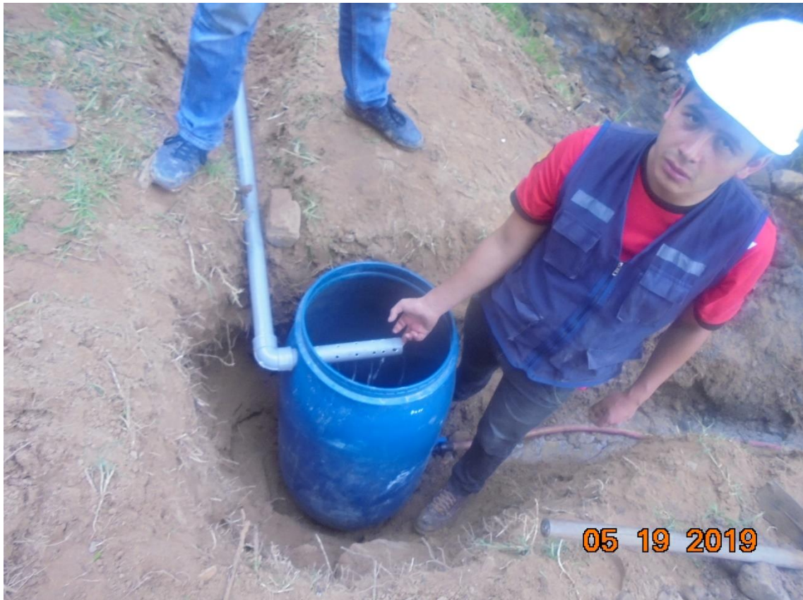
Figura 17. Inspección de la llegada del recurso hídrico que será tratada a través del filtro.
