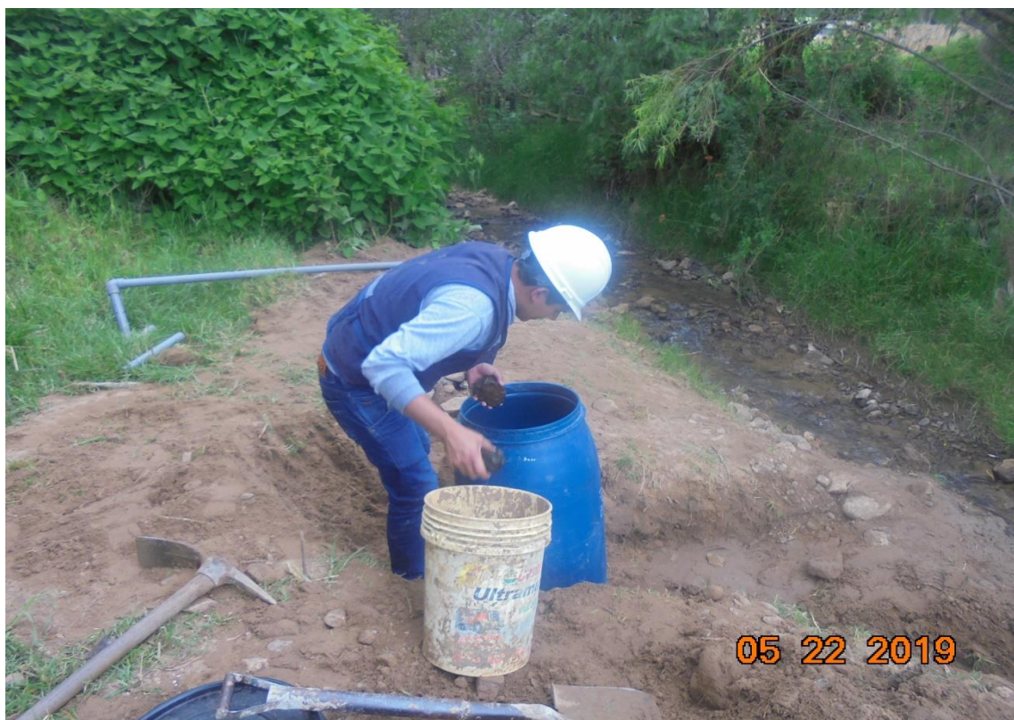
Figura 18. Colocación de los estratos al filtro.
