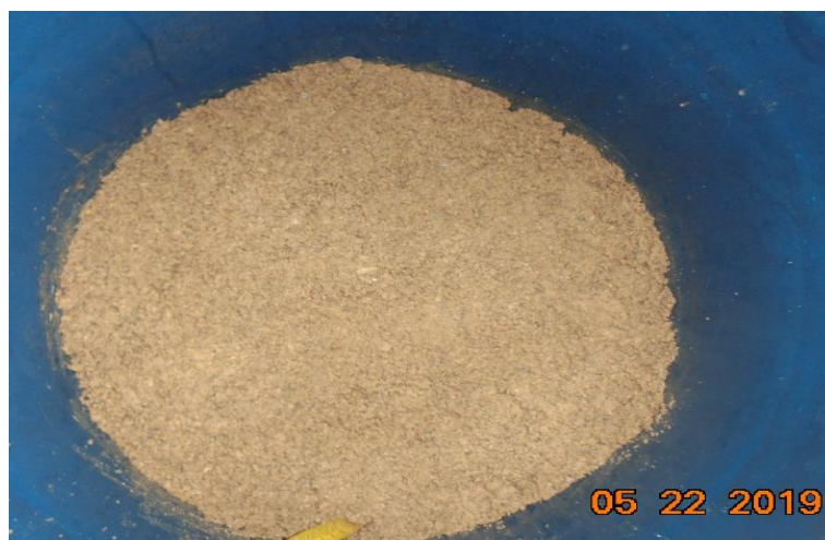
Figura 8. Colocación de la arena gruesa de río (h=0.05 m)
