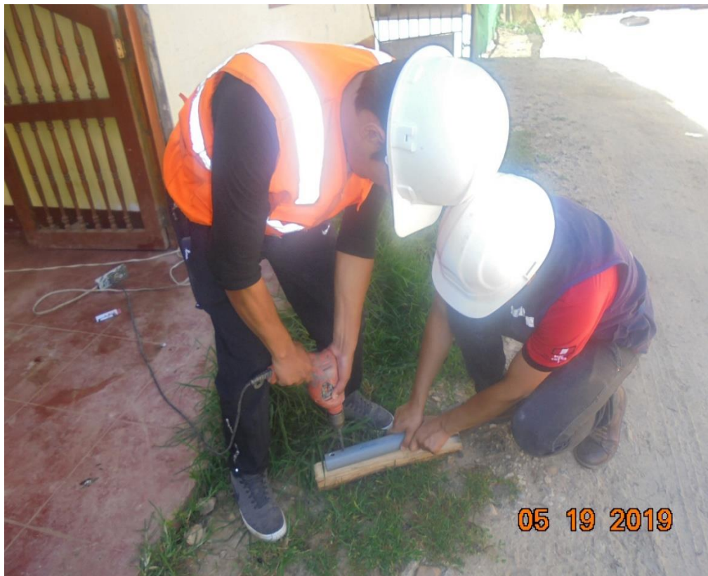
Figura 14. Tubería agujereada para ser implementada en el filtro.
