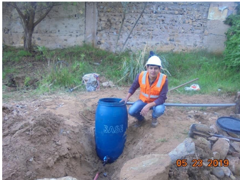
Figura 3. Instalación del filtro.
