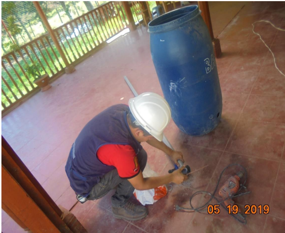
Figura 13. Instalación de accesorios del filtro.
