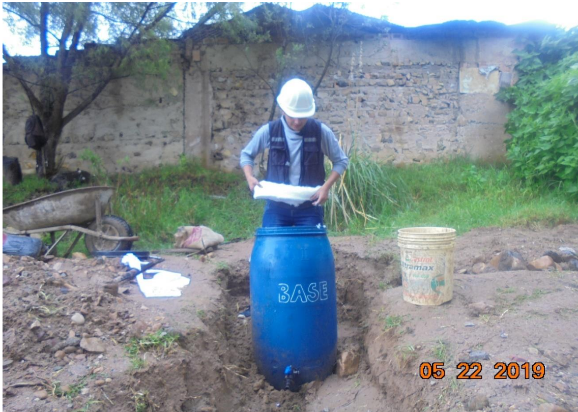
Figura 19. Colocación del algodón al filtro.
