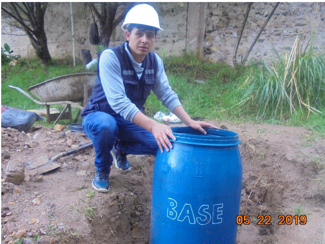
Figura 20. Filtro después de la colocación de los estratos.
