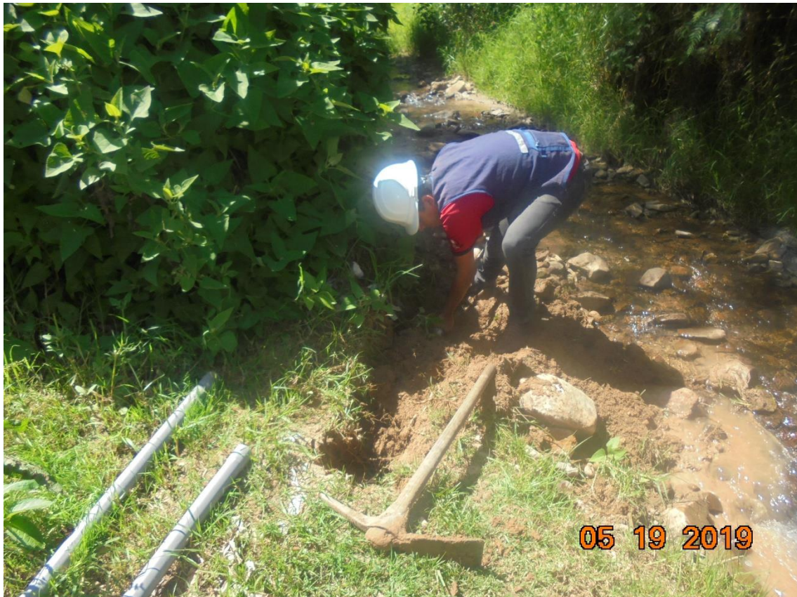
Figura 15. Excavación de zanja para el apoyo de la tubería.
