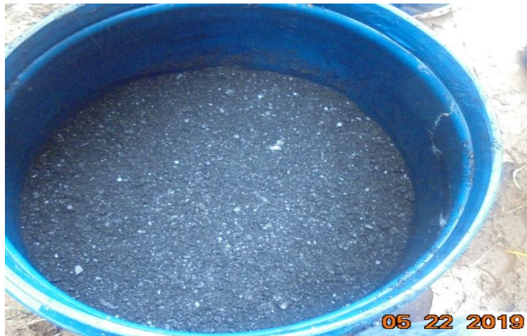
Figura 10. Colocación del carbón de antracita (h=0.20 m).
