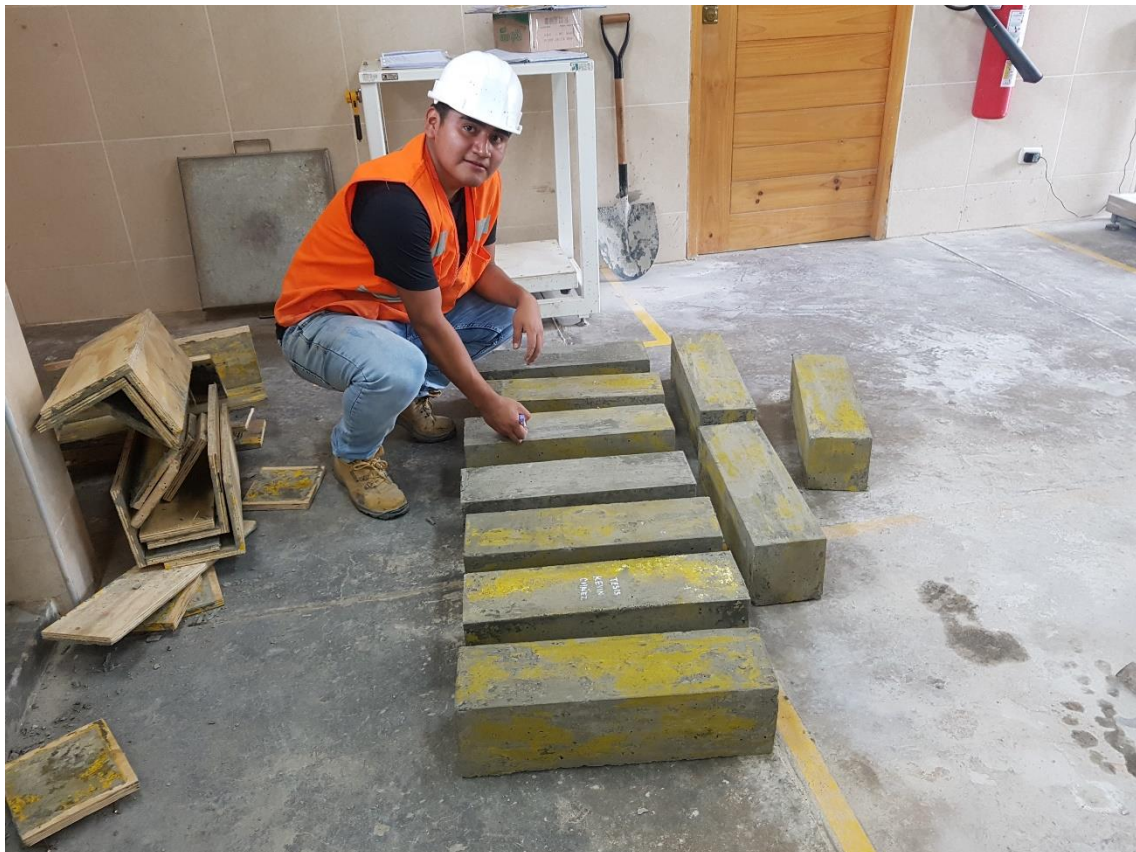
Fotografía N° 12 Desencofrado de vigas de concreto simple.
