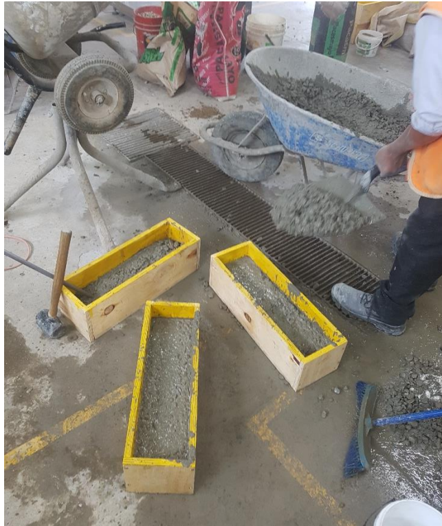
Fotografía N° 9 Elaboración de vigas de concreto simple.
