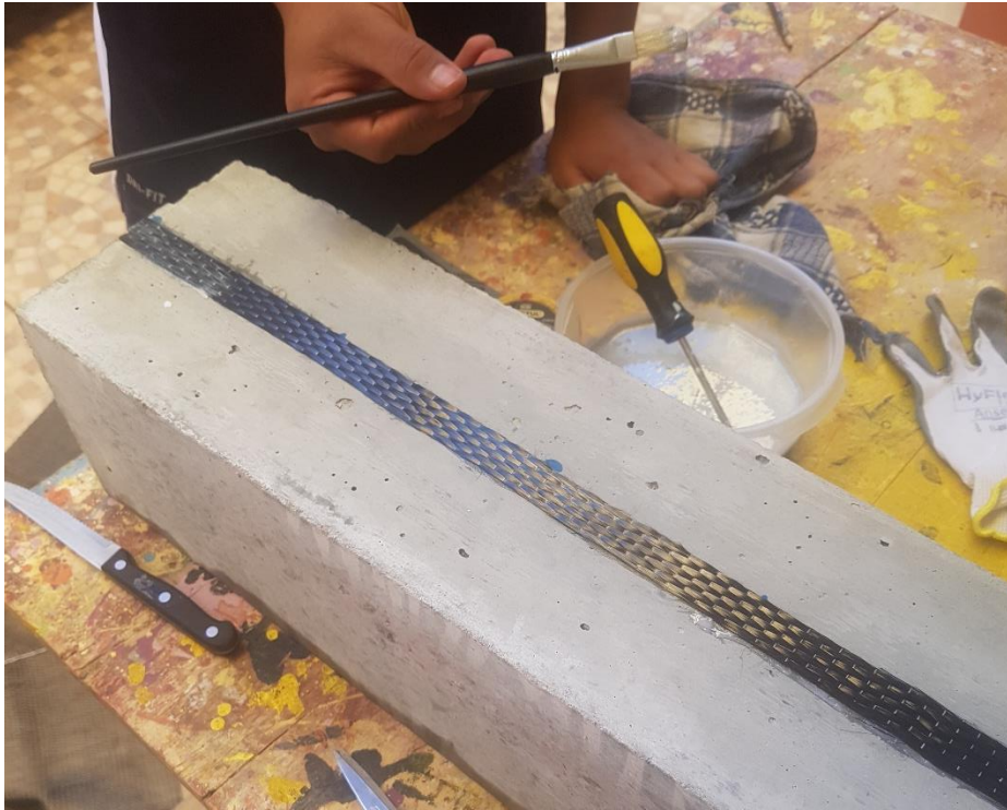
Fotografía N° 15 Adhesión de la fibra de carbono (SikaWrap-600C).
