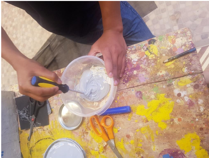
Fotografía N° 14 Mezclado de la resina de impregnacion (Sikadur-301).
