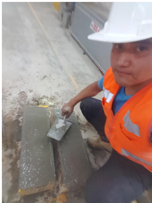
Fotografía N° 10 Enrrasado de vigas de concreto simple.
