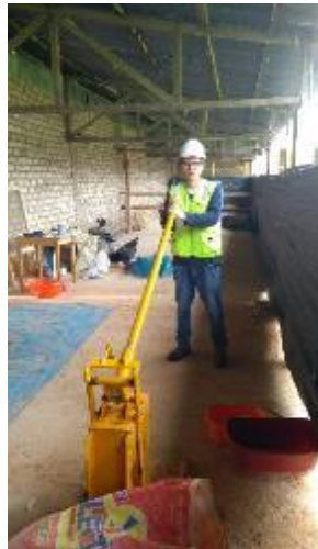
Imagen 16: Compactación o compresión de los suelos y las mezclas estabilizadas mediante palanqueo en la maquina CINVA RAM
