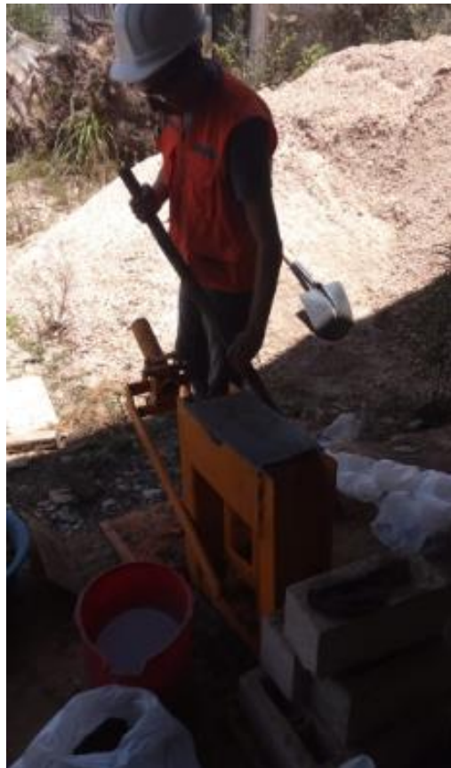
Fotografía N° 29: Realizando los adobes en la máquina CIMVA RAM
