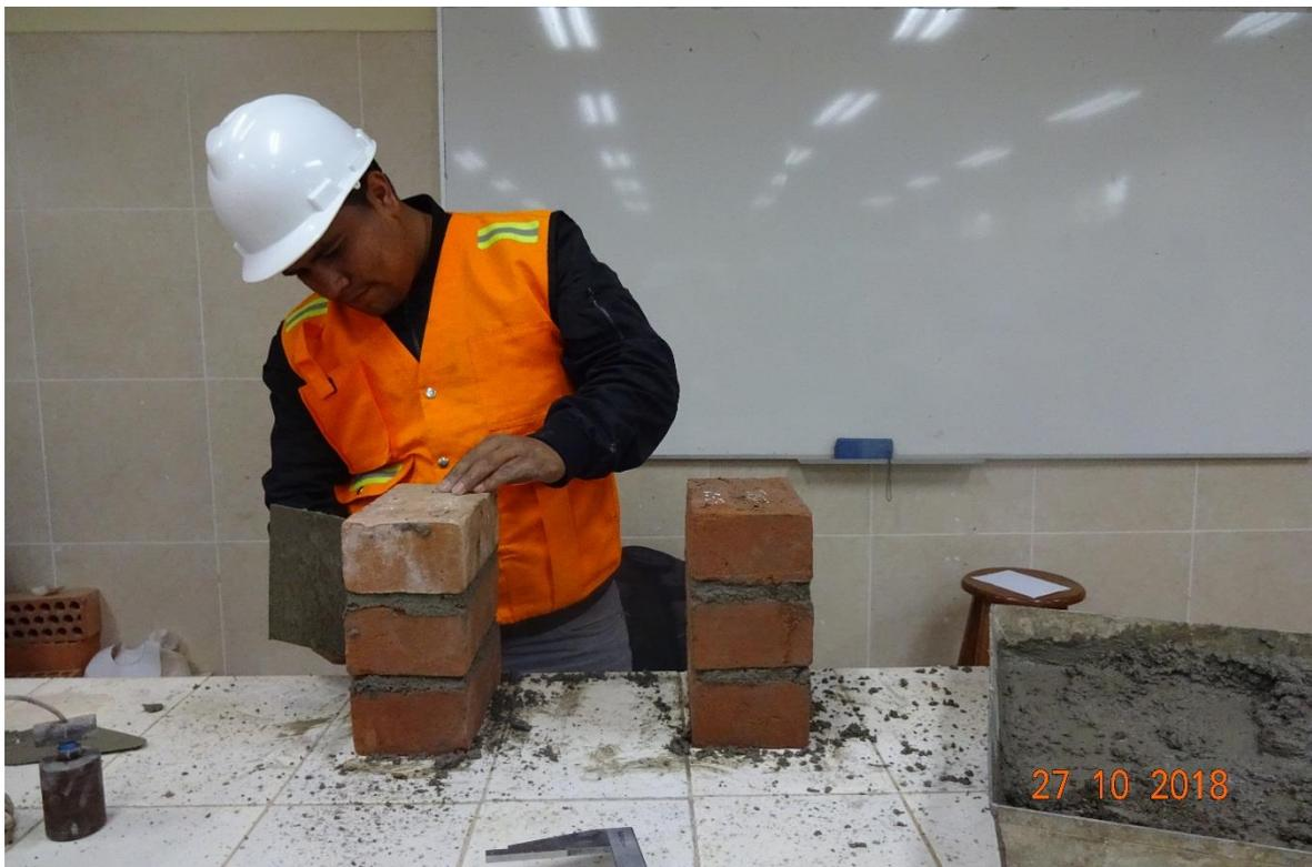
*Fotografía 40: Construcción de pilas y asentado de ladrillo.*
