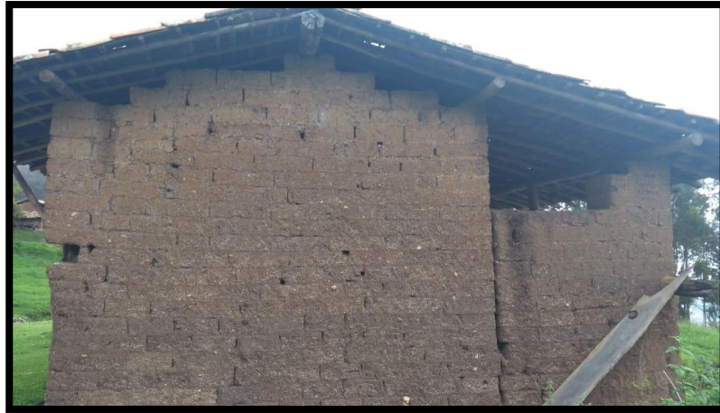
Techo mal apoyado sobre muro y ausencia de viga collar.
