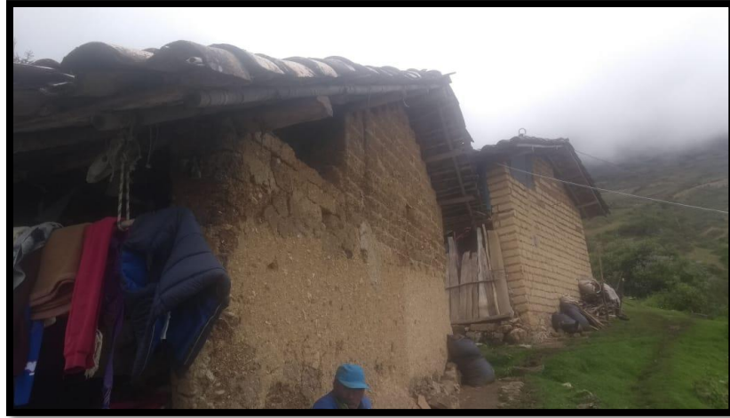
Vivienda del fondo: mejora de muro y contrafuerte.
