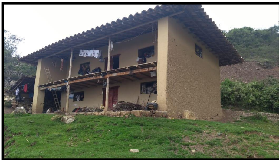
Vivienda mejorada con arriostres horizontales, vanos bien distribuidos y contrafuertes adecuados.
