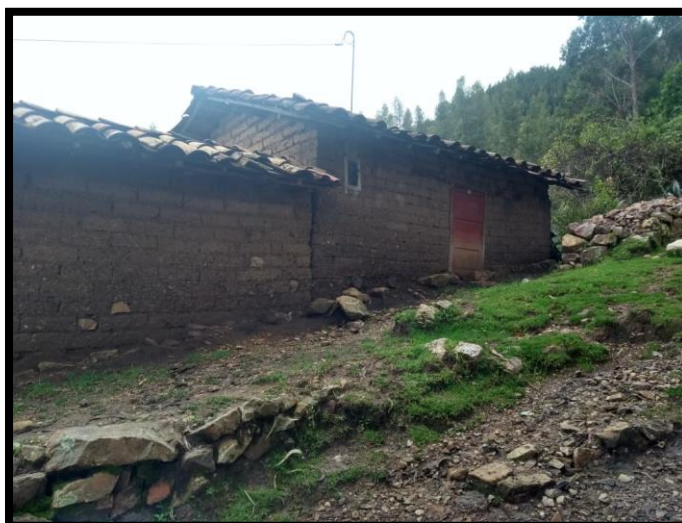
Alero con menos de 1m de voladizo.
