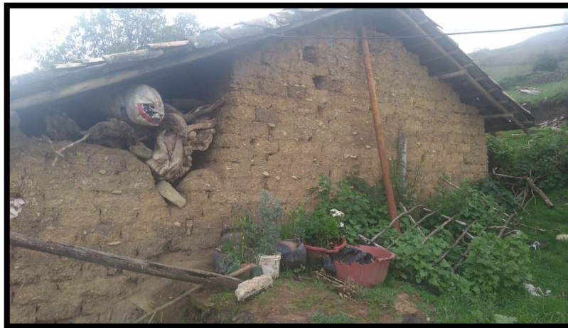
Techo mal apoyado sobre muro y ausencia de viga collar.
