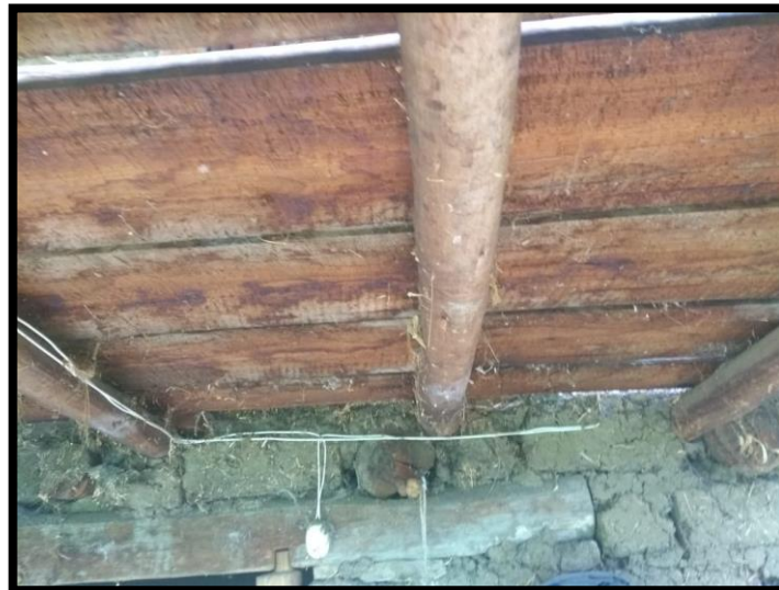
Apoyo de vigas de eucalipto sobre dintel.
