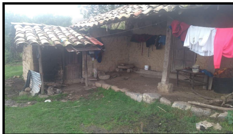
Construcción que incumple la norma y además da muy mala calidad de vida
