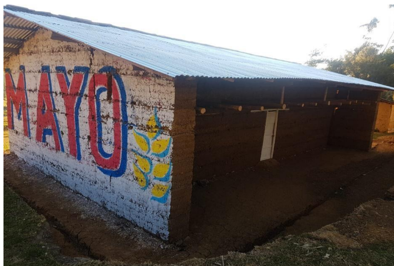
Figura 24. Construcción 02, corrección de muros, retoque con barro, mejora de la viga de soporte. Fuente: Elaborado por los Autores – Trabajo de campo
