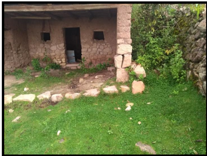
Inadecuada cimentación.
