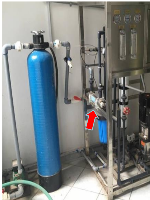
Figura 24. Lámpara ultravioleta. Fuente: Empresa Tecnología de Membranas.
