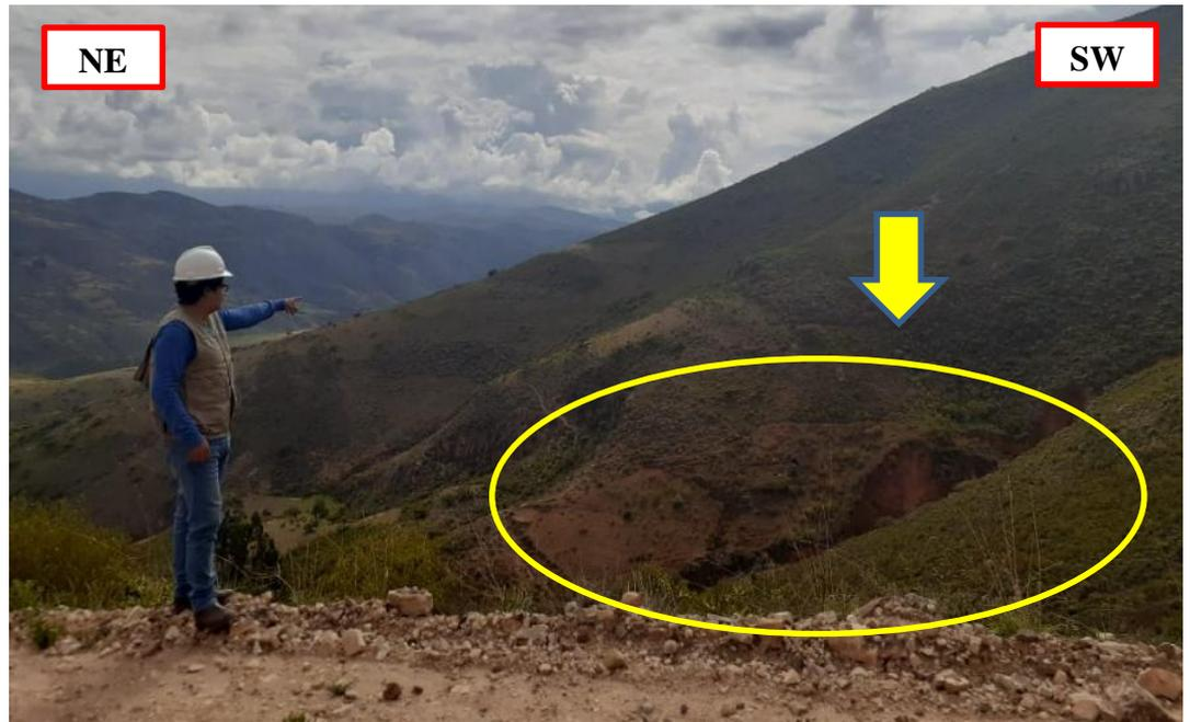
**FIGURA 22:** Socavamiento producto de la erosión fluvial y flujo de tierra
