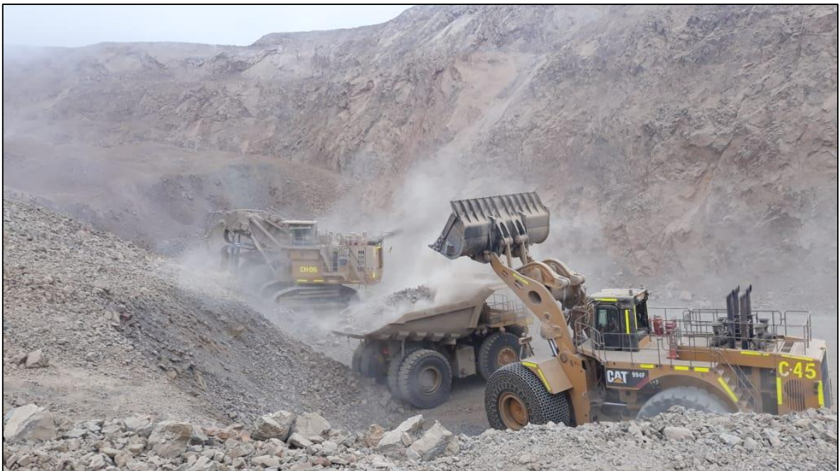
Figura 25. Actividad de carguío en mina.
