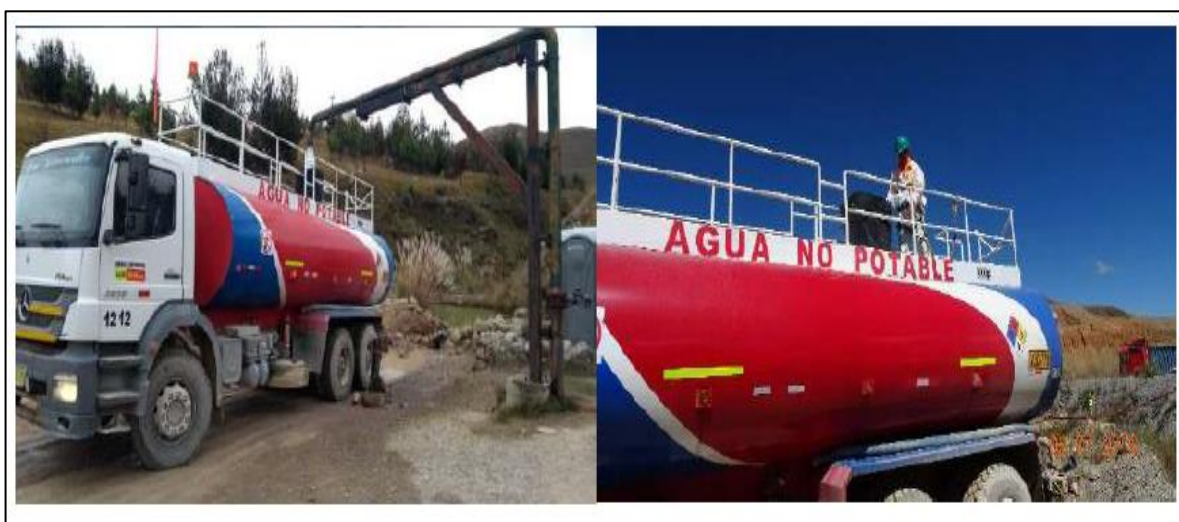
Foto 2. Abastecimiento de cisterna de agua, en el transcurso del llenado se vierte el producto supresor de polvo aditivo DL10 Plus, con la finalidad de conseguir una mezcla homogénea.
