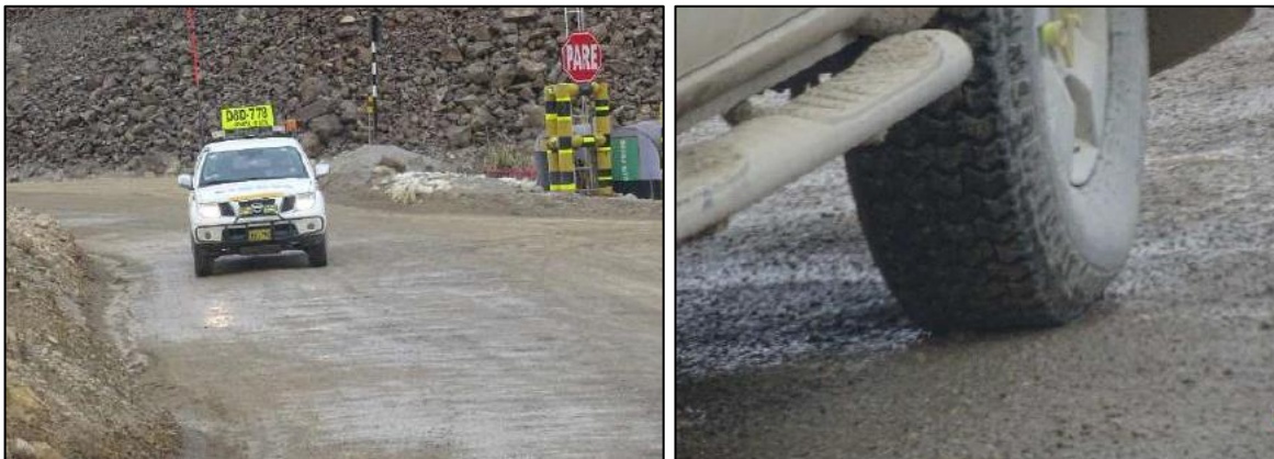
Foto 4. Se evidencia que con el uso del supresor de polvo DL10 Plus se genera control de la generación de polvo particulado en las vías de servicio activo PCS.
