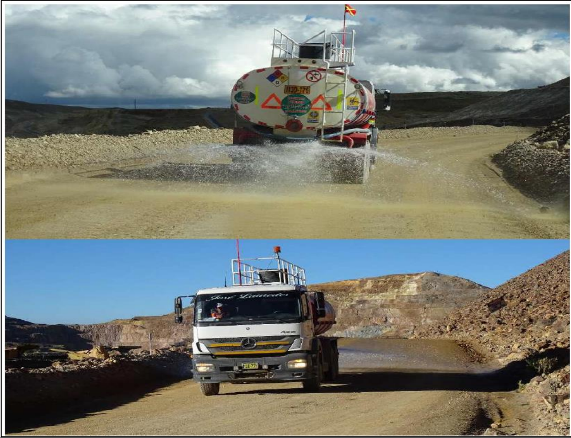
Foto 3. El programa de aplicación consistió en regar diariamente con agua más producto supresor DL10 Plus, riegos de lunes a viernes desde las 6:45am hasta las 5pm; sábados de 6:45am hasta 13:30pm y los domingos desde 6:45am hasta 13:30pm.
