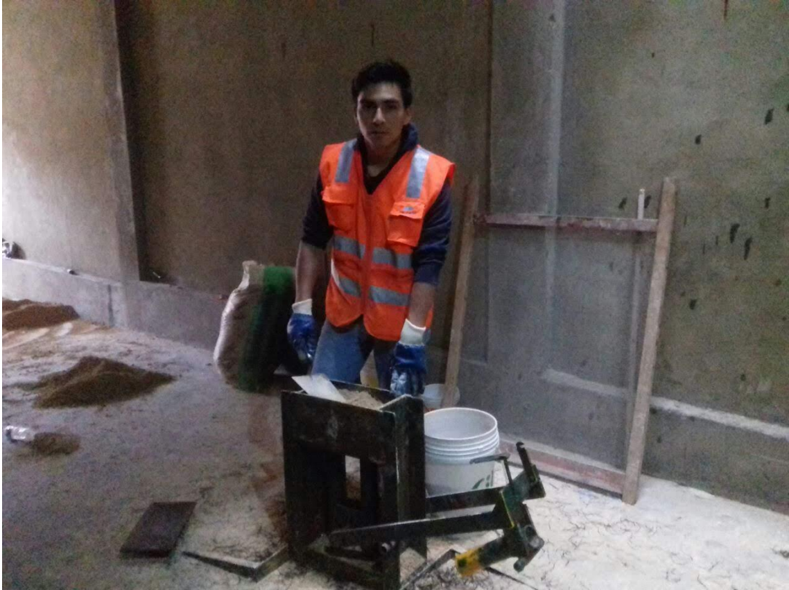
Fotografía 13. Elaboración de adobes.
