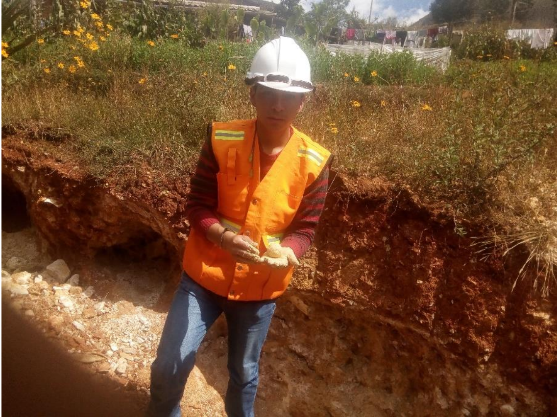
Fotografía 3. Prueba de presencia de arcilla recomendada por la norma E-080.
