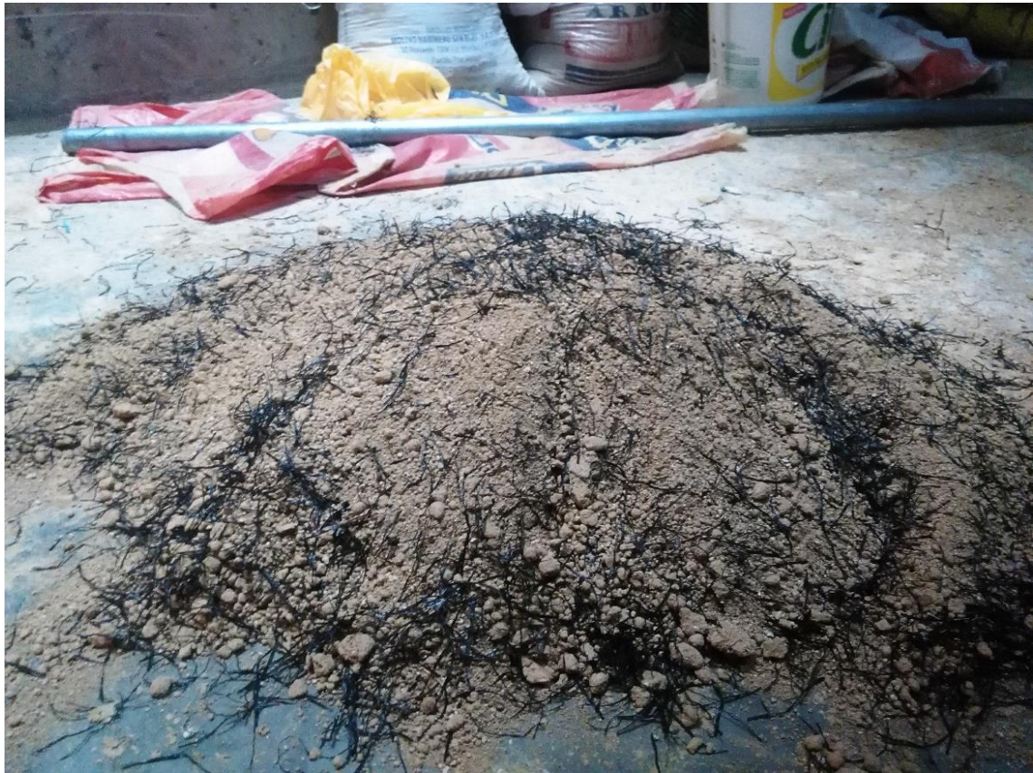
Figura 30 Preparación de la mezcla para realizar los bloques de adobes.
