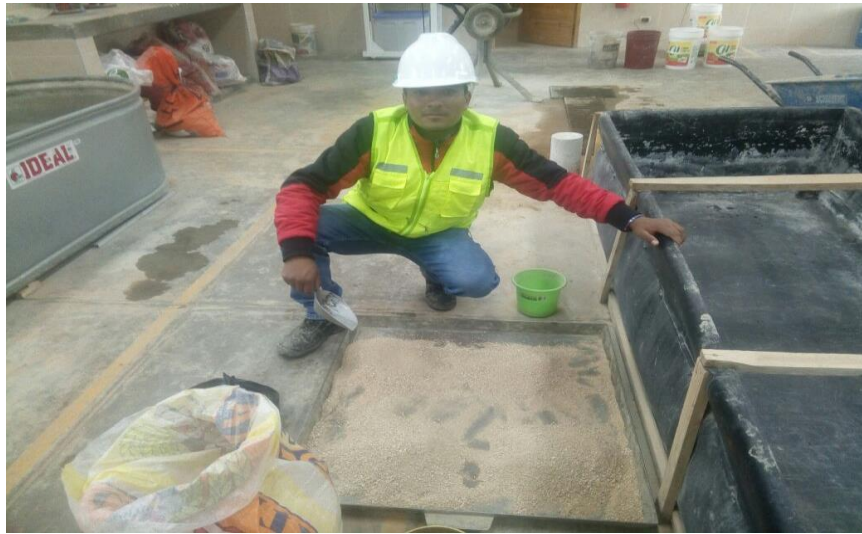
Figura 12 Preparando el material para realizar el Proctor
