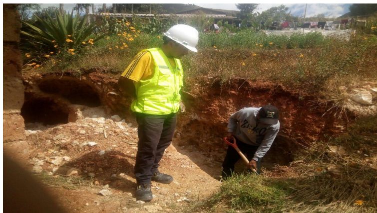
Figura 4 Sacando el material de la calicata en el Distrito Cajamarca, caserío Cruz Blanca – Aylambo.
