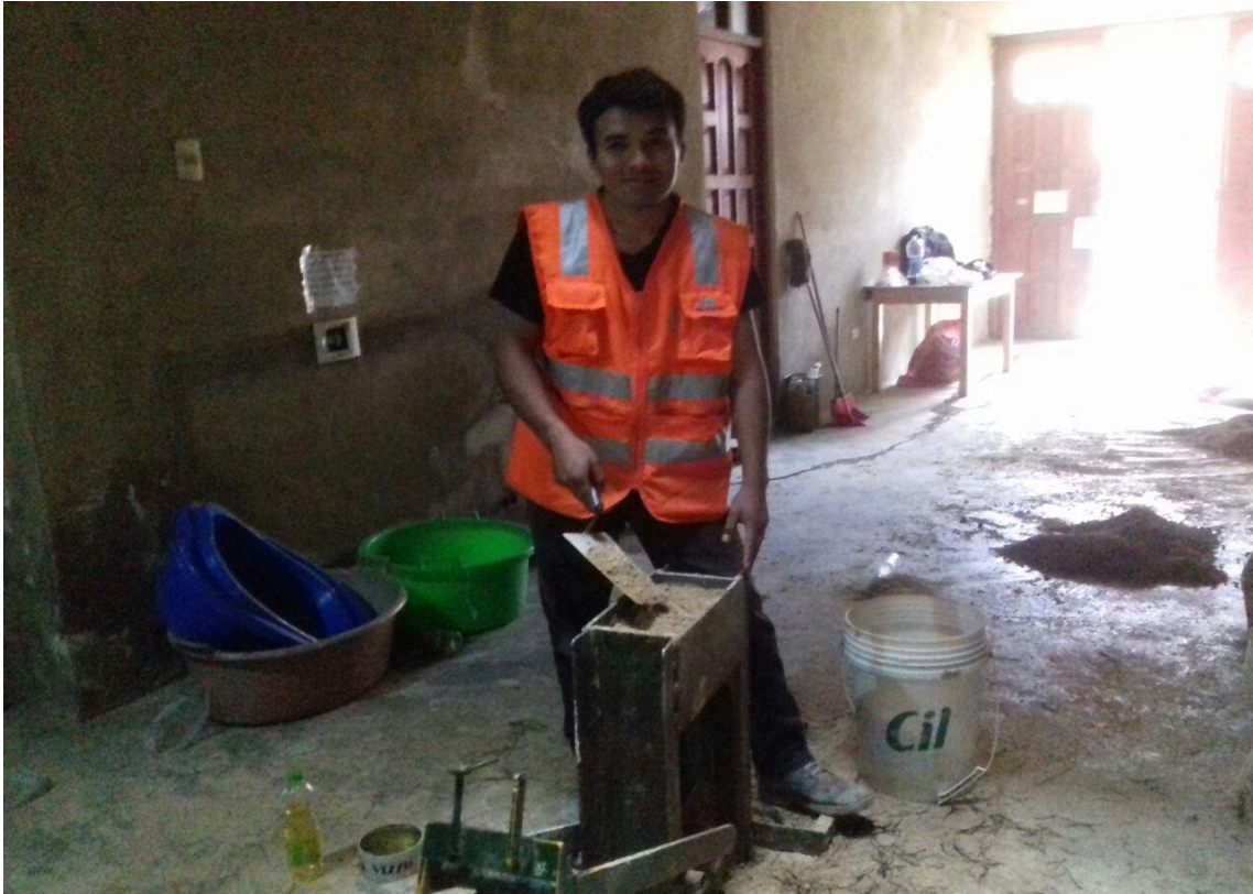
Figura 31 Colocación del material para moldar el adobe.
