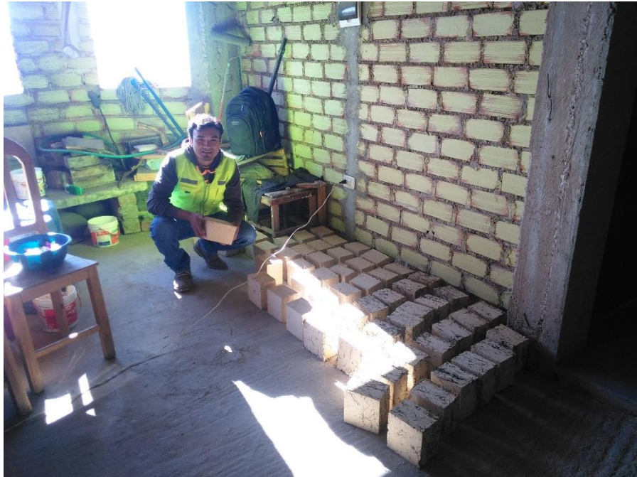
Figura 17 Secado de los bloques de adobe a 28 días bajo techo.
