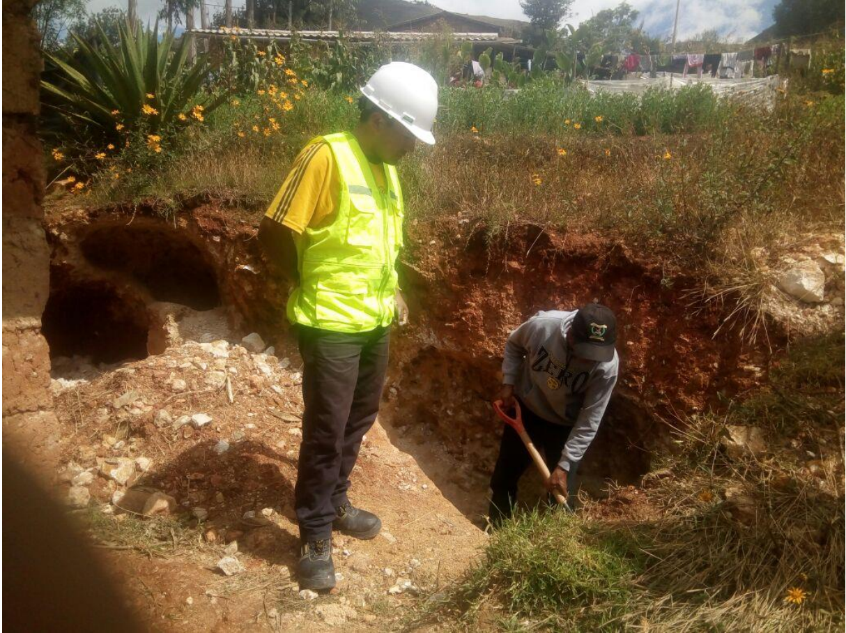
Figura 22 Extracción del material de la cantera “Aylambo”.
