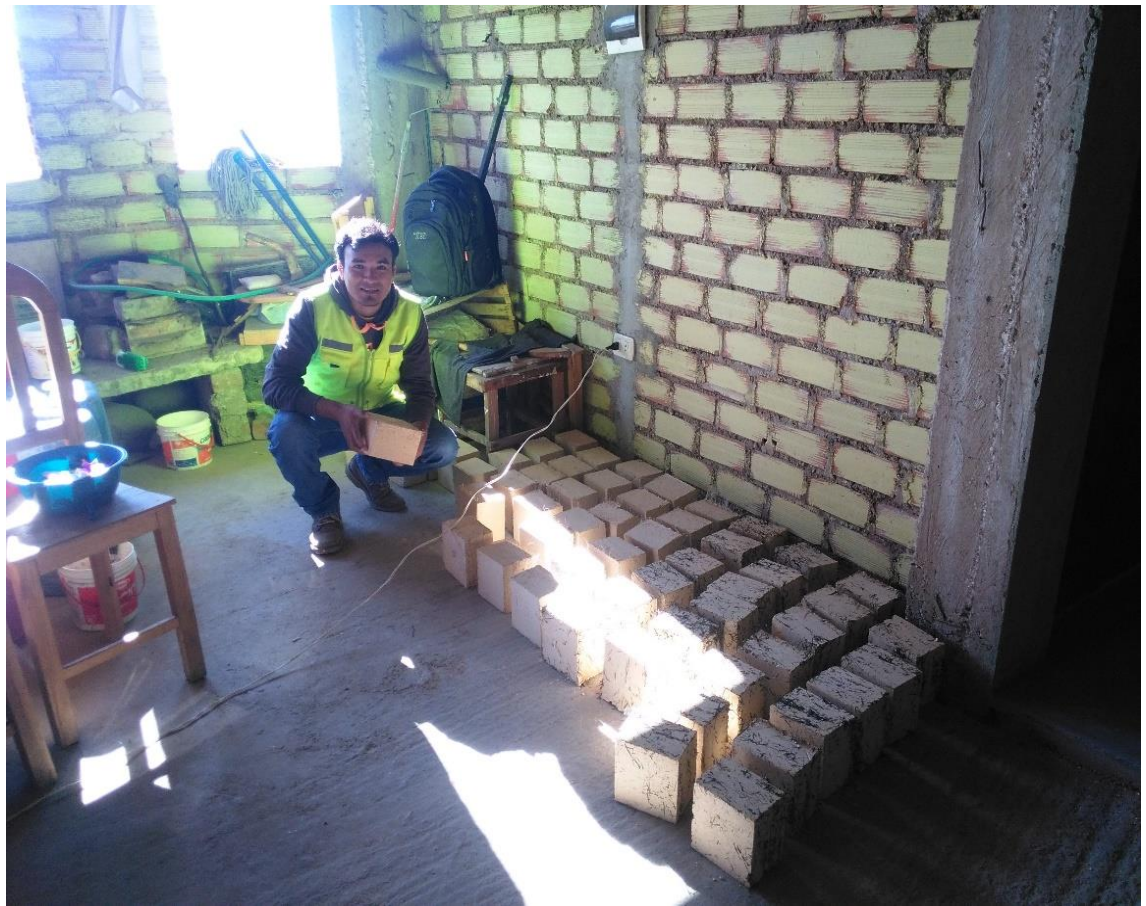
Figura 34 Secado del adobe bajo techo.
