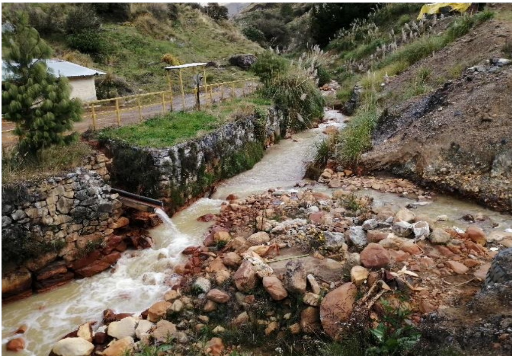
Foto 2. Intersección de la Quedra “LA M”, Río Tingo Maygasbamba y drenaje ácido.
