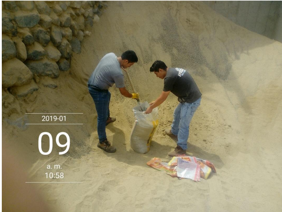
Figura 43 Extracción de los agregados en la cantera ‘La Soledad’
