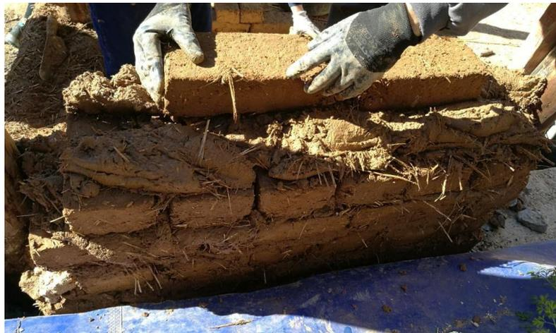
Figura 1: Muro de adobe con implementación de fibras naturales (Espinosa ,2019)
