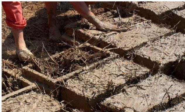
Figura 3: Conformación de adobe con fibras naturales
