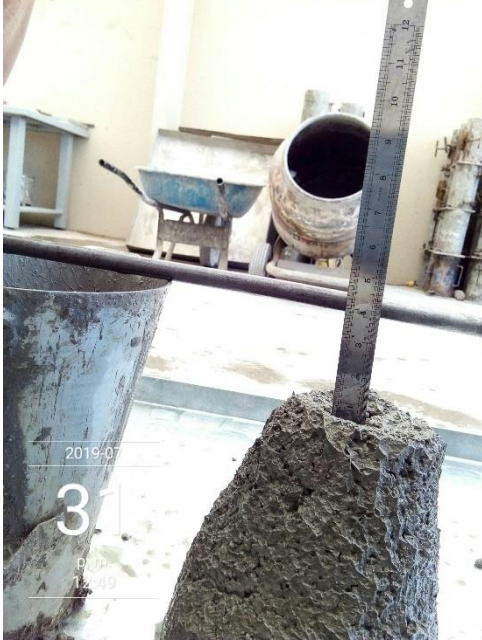
Figura 59 Toma de medida de Slump de 4"
