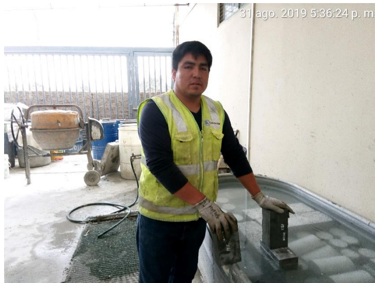
Figura 7: Ingreso de adoquines en la poza de curado
