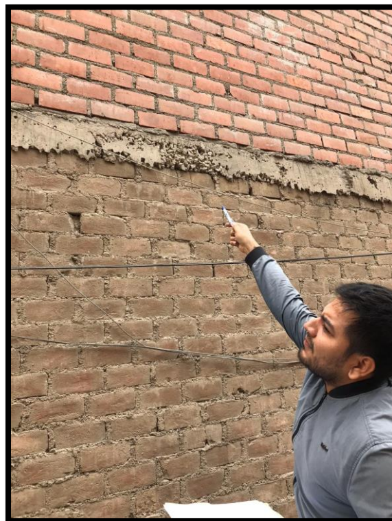
Figura 53: Armadura expuesta
