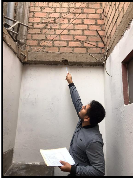
Figura 56: Armadura expuesta
