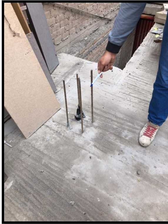
Figura 52: Armadura expuesta
