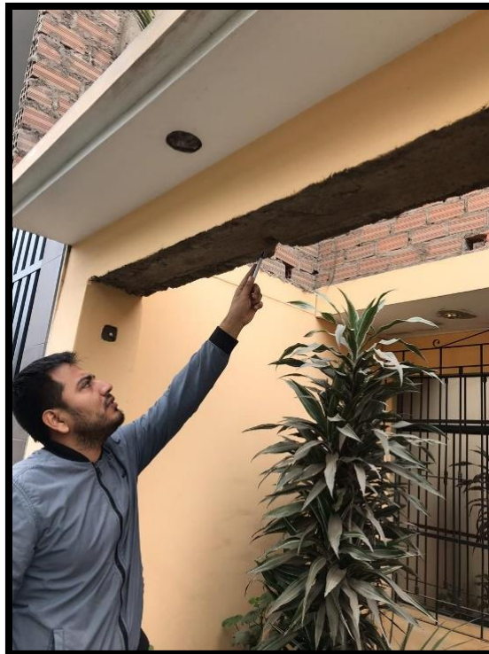
Figura 51: Armadura expuesta
